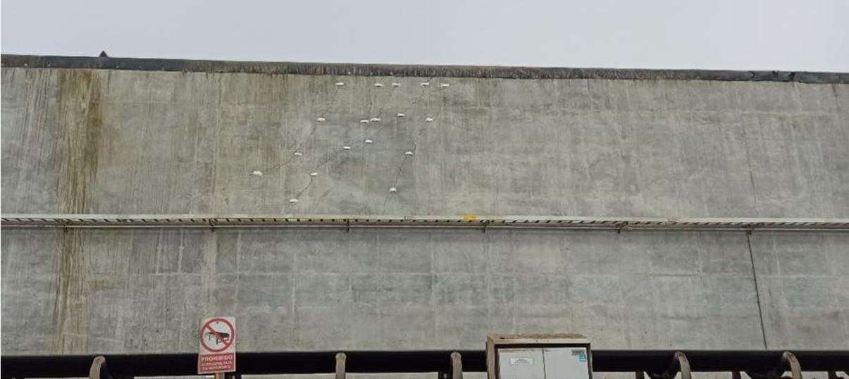
*Nota: Se muestran fisuras al lado de un muro divisorio, las fisuras están siendo monitoreadas con placas de yeso.*
