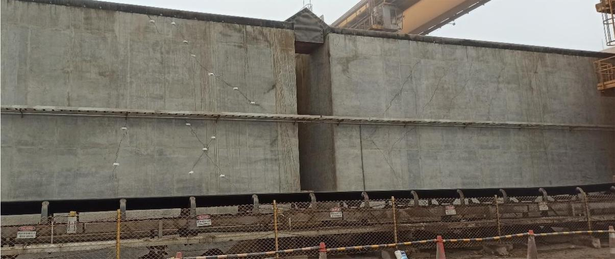
*Nota: Se muestran fisuras al lado de los muros extremos en la parte superior, algunas fisuras están siendo monitoreadas con placas de yeso. También se muestran otras fisuras diagonales en la parte inferior en sentido contrario a las diagonales superiores.*
