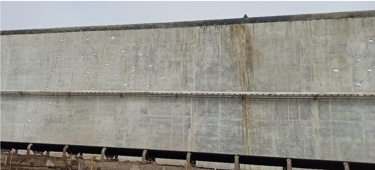
*Nota: Se muestran fisuras en ambos lados de un muro divisorio, las fisuras están siendo monitoreadas con placas de yeso.*
