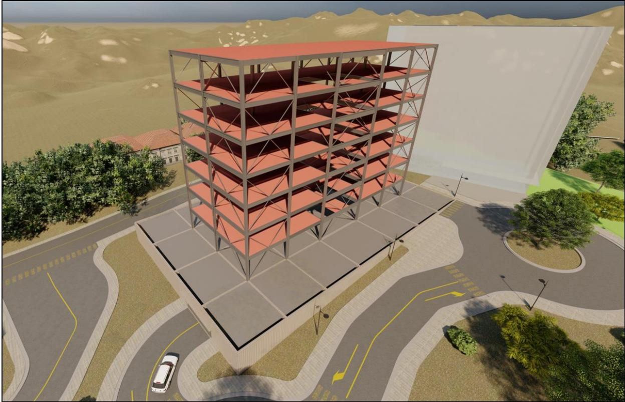
Figura 4.10 Estructuración con base en aislamiento sísmico Sentido X y Y - OCBF
