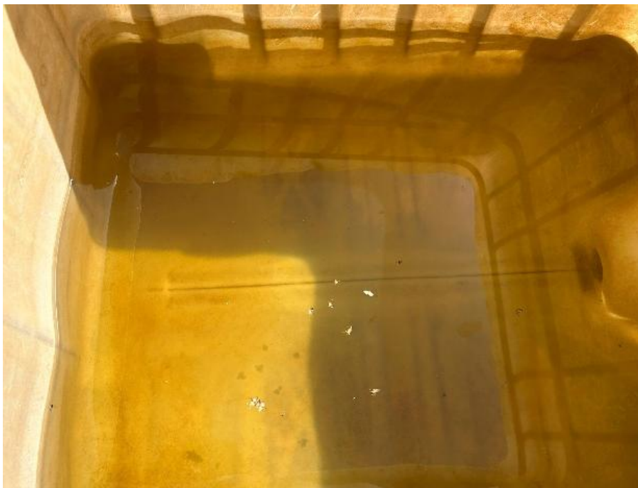
Figura D: Sancada (precipitación antes de recircular)
