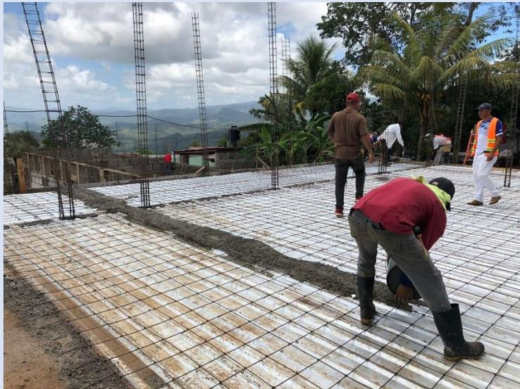
Ilustración 44. Colocación de las guías para el llenado de losa de entrepiso. Fuente Propia 2022
