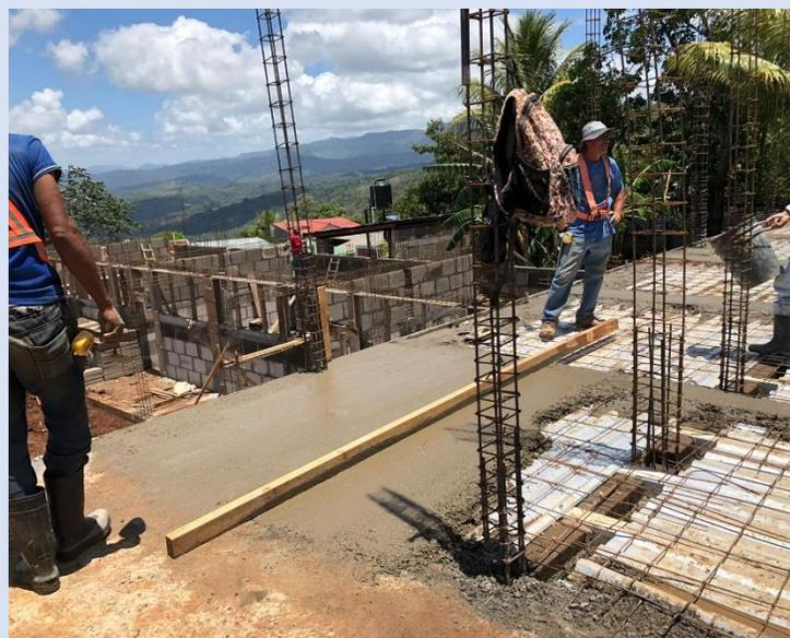
Ilustración 45. Distribución uniforme del concreto. Fuente propia 2022
