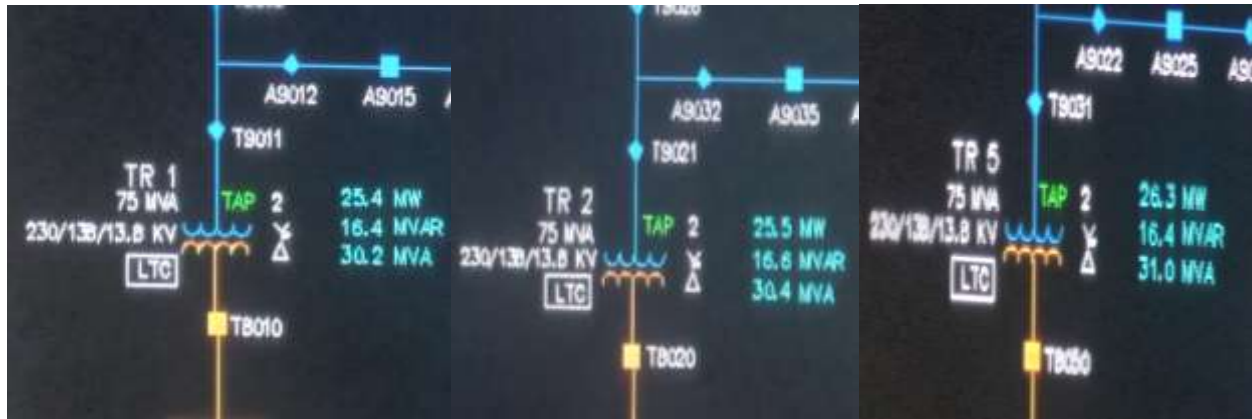
Figura 7. Autotransformadores de la subestación eléctrica análoga Masaya.
