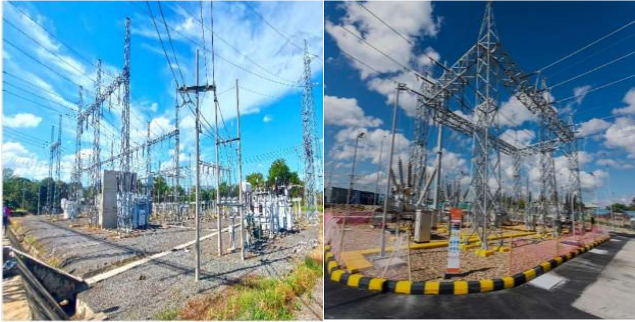
Figura 28. Subestación eléctrica análoga vs Subestación eléctrica digital en cuestión de tamaño.
