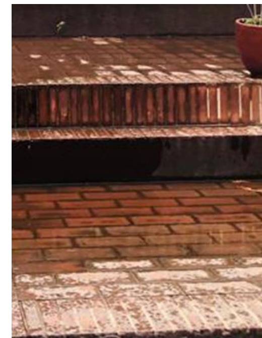
Imagen 55. Piso en plazoleta A. Fuente: Propia.
