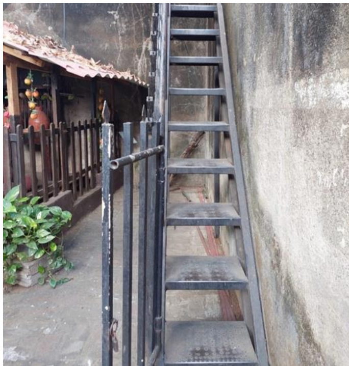
Imagen 51. Vista frontal de escalera metálica. Fuente: Propia.
