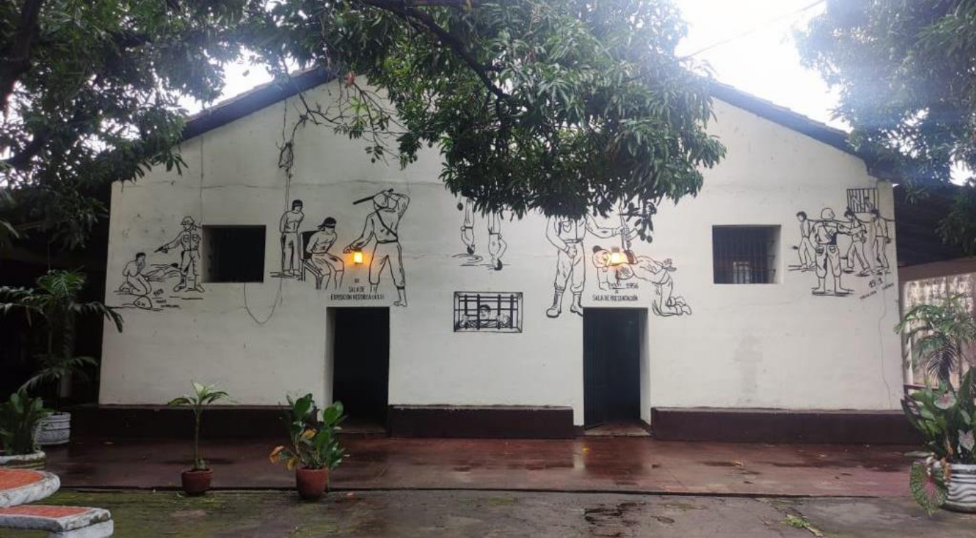
Imagen 77. Estado actual de la fachada sur edificio principal. Fuente: Elaboración propia.
