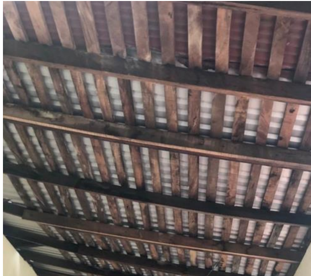
Imagen 49. Vigas tensoras y clavadores de madera ubicadas en pasillo de circulación este. Fuente: Propia.
