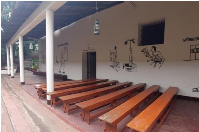
Imagen 41. Vista fachada este. Fuente: Propia.
