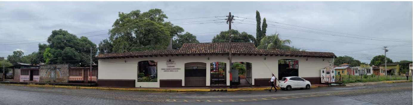
Imagen 37. Vista panorámica fachada principal de la obra en estudio. Fuente: Propia.
