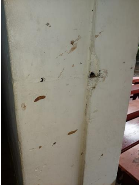
Imagen 45. Espesor de muro de sala de personajes históricos (sala II). Fuente: propia.
