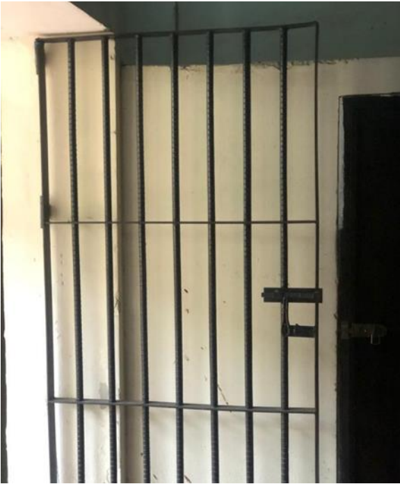
Imagen 47. Puerta metálica ubicada en sala de personajes históricos (sala II). Fuente: Propia.
