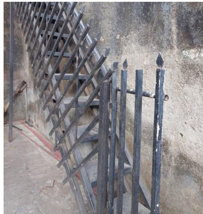
Imagen 52. Vista lateral de escalera metálica. Fuente: Propia.
