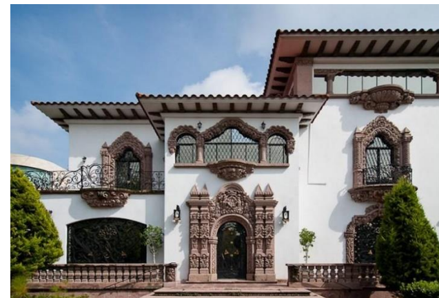
Imagen 29. Casa de habitación, colonia Polanco, ciudad de México. Fuente: MXcity, 2022.
