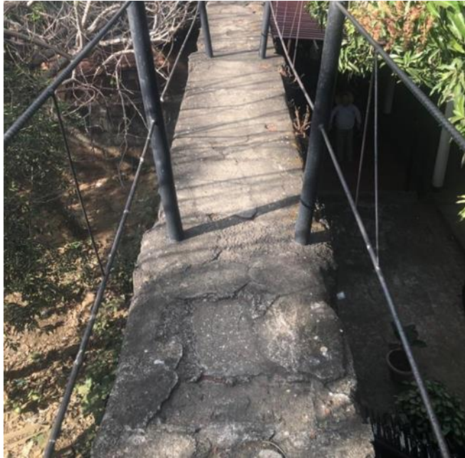
Imagen 46. Vista superior de muro perimetral norte. Fuente: Propia.
