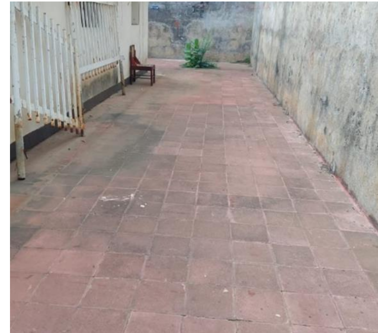
Imagen 53. Vista panorámica de piso en costado norte. Fuente: Propia.
