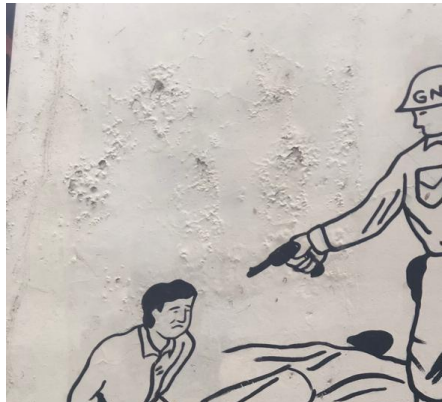
Abofamiento y Desprendimiento
