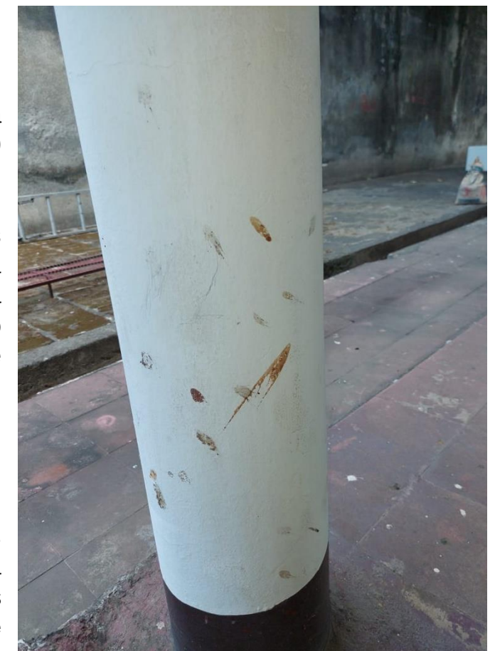
Imagen 44. Columna de sección circular ubicada en eje E. Fuente: propia.
