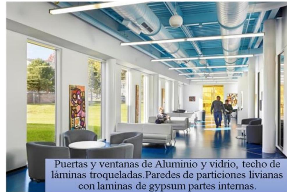
Puertas y ventanas de Aluminio y vidrio, techo de láminas troqueladas. Paredes de particiones livianas con laminas de gypsum partes internas.
