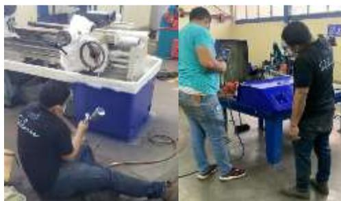
Figura 12: Aplicación de Pintura al torno
