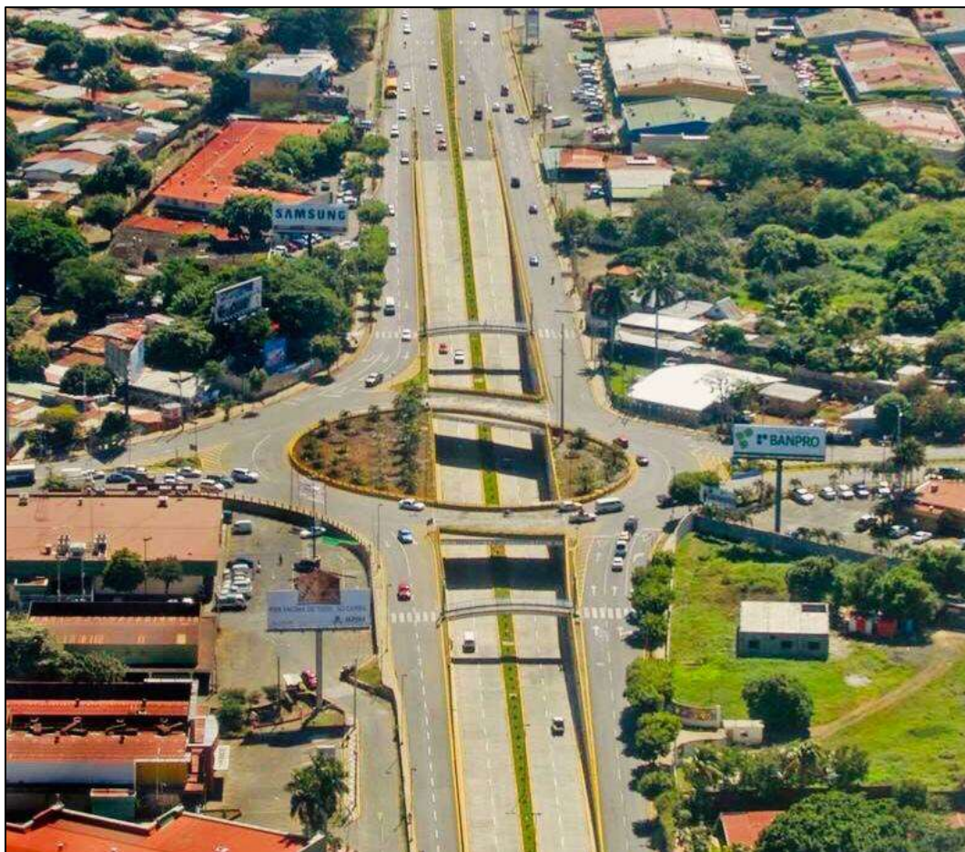
Figura N°33. Paso a desnivel Rotonda Centroamérica
