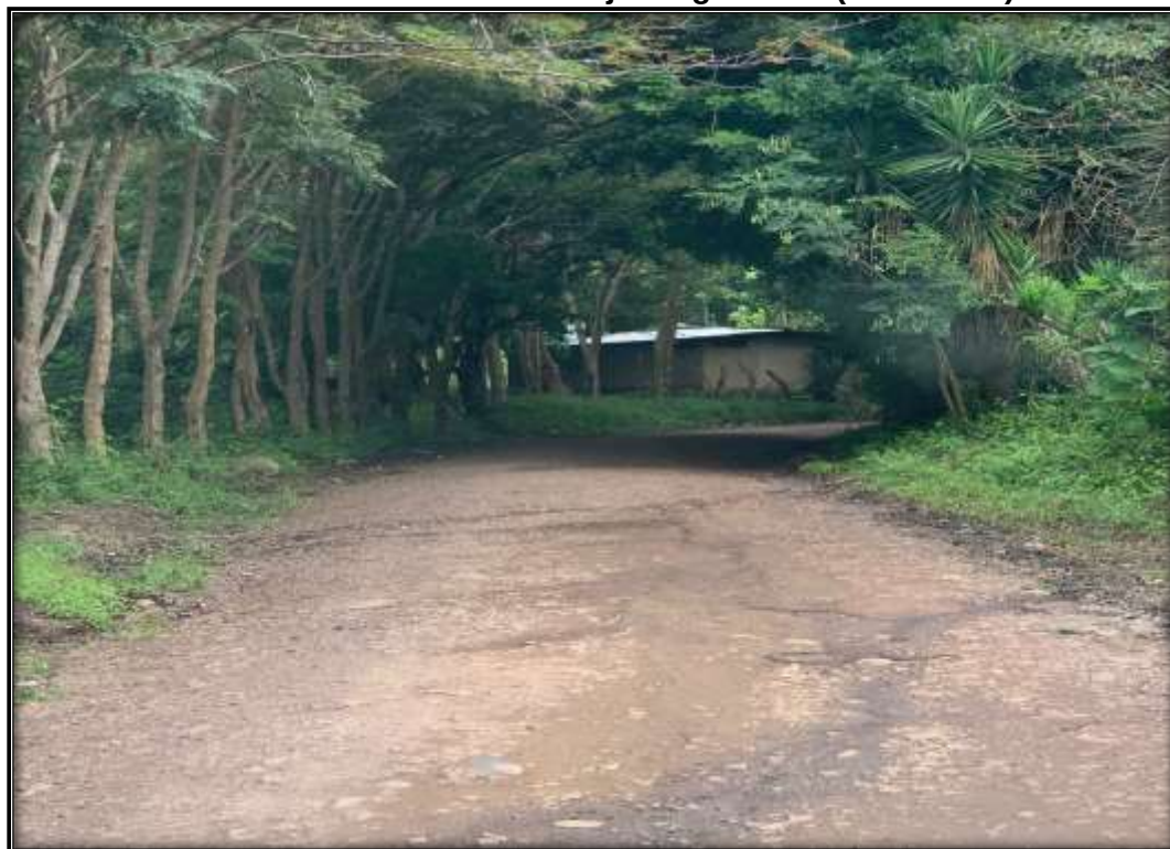
Foto 6. Inexistencia de drenaje longitudinal (Est. 0+640).
