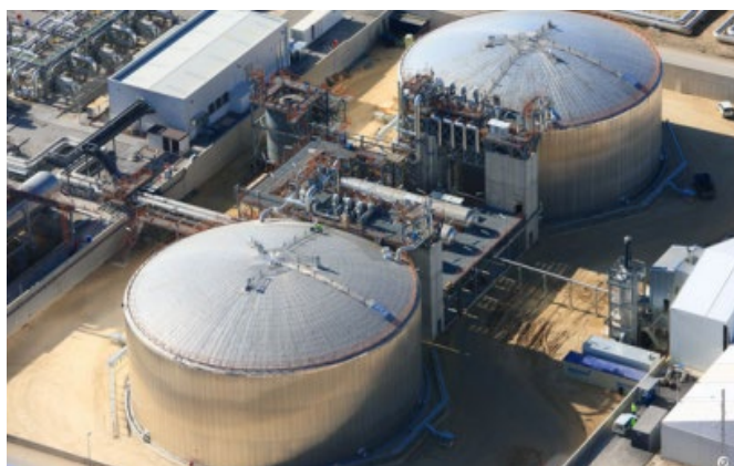
Figura 12: Sistema de almacenamiento térmico Fuente: https://www.energias-renovables.com/termosolar/la-termosolar-podria-aportar-al-sistema-electrico-20201020
