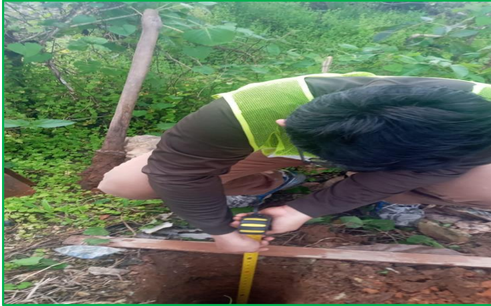
Fotografía 2: Excavación del suelo de la línea del proyecto
