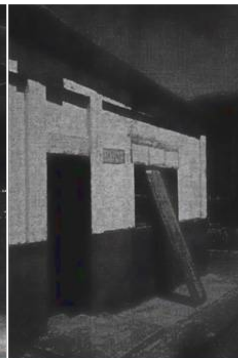
Figura 10.vista norte edificio de corraleta, Fuente : Escuela Taller Acahualinca, febrero 2010
