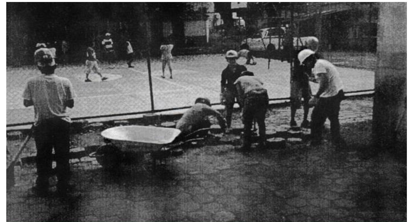
Figura 16. colocacion de adoquines en zonas entre edificios Fuente : Escuela Taller Acahualinca. junio 2010
