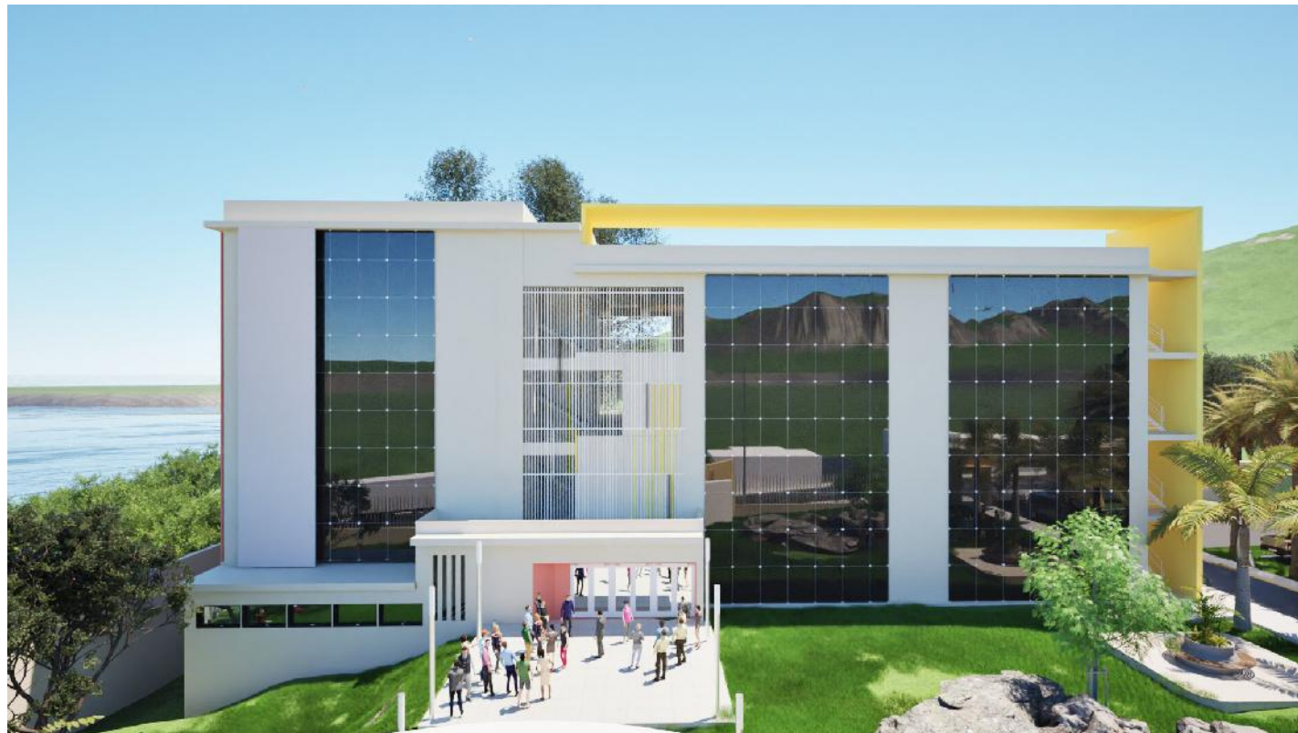
Fachada principal de acceso al edificio Centro Tecnológico
