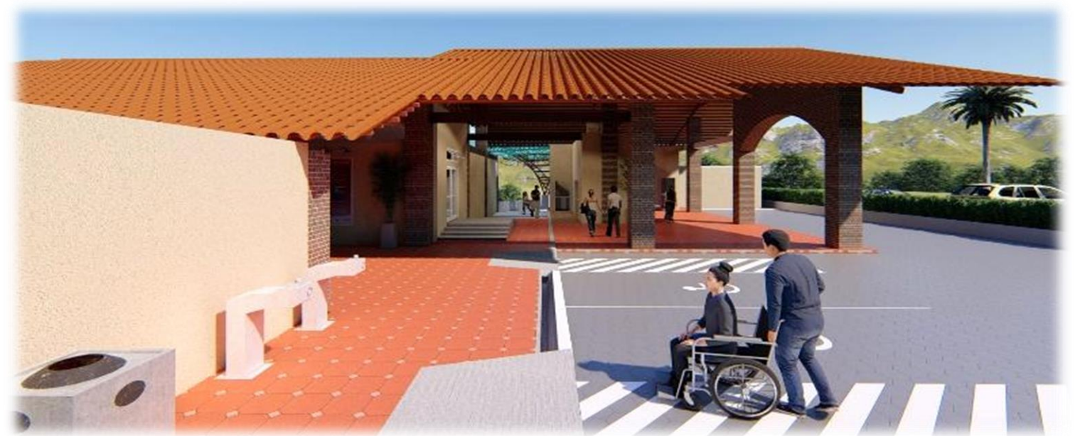
Imagen 76. Cubierta principal del CTHSJ de tejas de barro sobre láminas de zinc ondulado.
