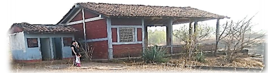
Imagen 6. Levantamiento ínsito actual del (CTHSJ). Vista norte.
