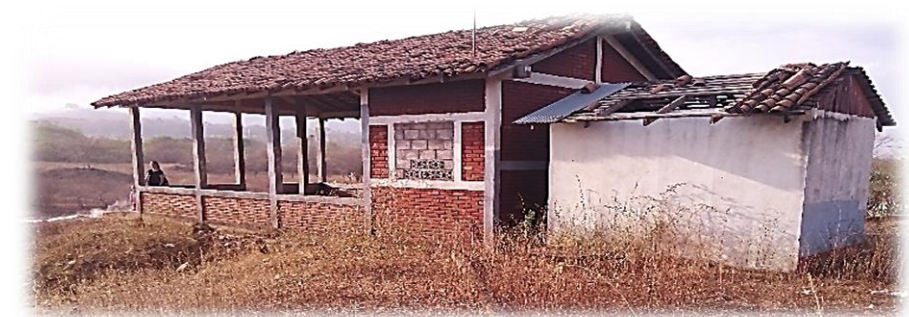
Imagen 8. Vista Sur del (CTHSJ). Estado actual
