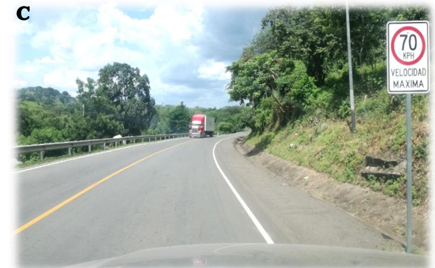
Imagen 32. Estado de las vías próximas al sitio.
