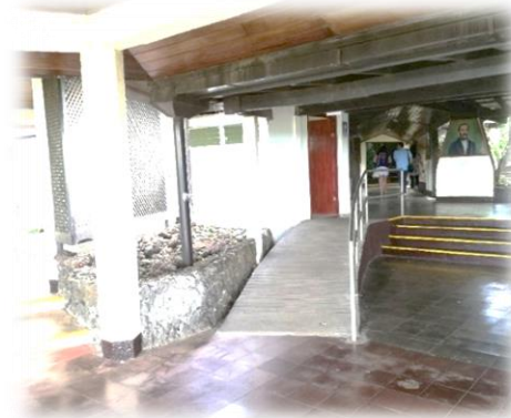
Imagen 51. Acceso con rampa a una parte del mirador costado sur conectado con área de parqueo vehicular.
