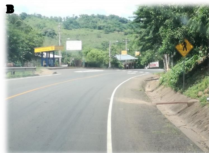
Imagen 31. Estado de las vías próximas al sitio.
