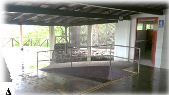
Imagen 45. Acceso a servicios sanitario hombre y rampa de acceso hacia mirador.
