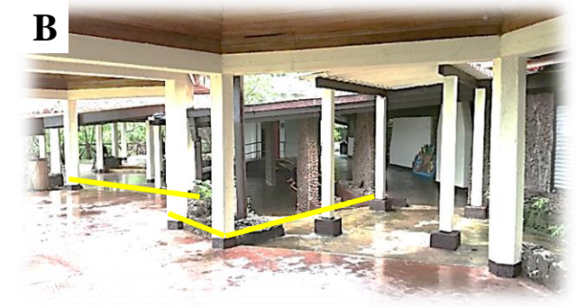
Imagen 47. Sin rampas de acceso a mirador bajo techo.
