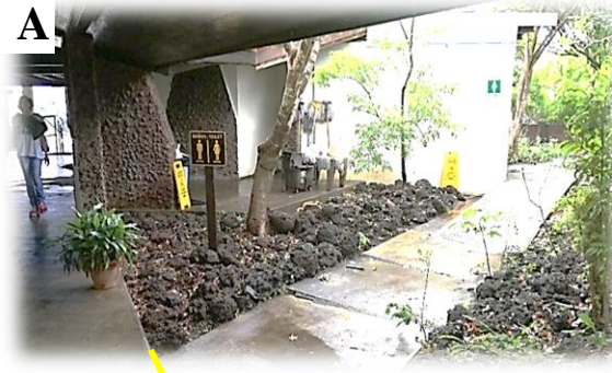
Imagen 43. Acceso peatonal a Baños Mujeres no cuenta con rampas de acceso.
