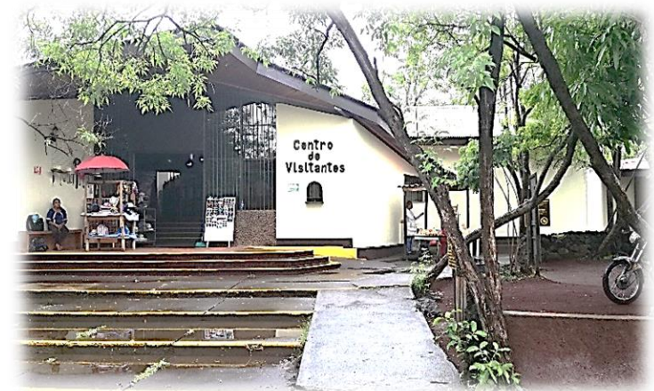
Imagen 34. Rampas de acceso a personas capacidades diferentes.
