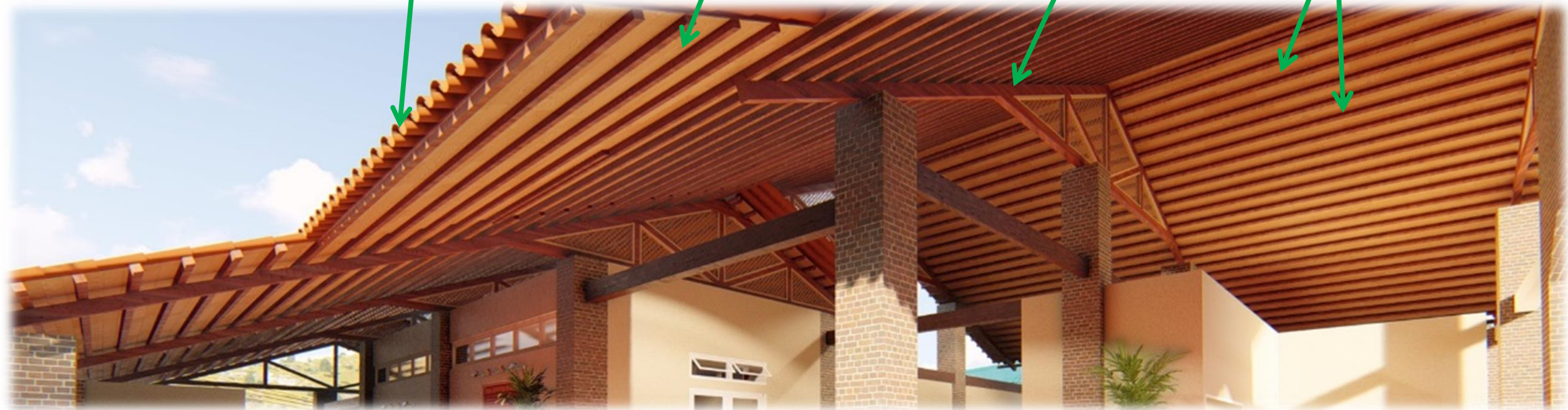
Imagen 74. Estructura y cubierta de techo del CTHSJ.
