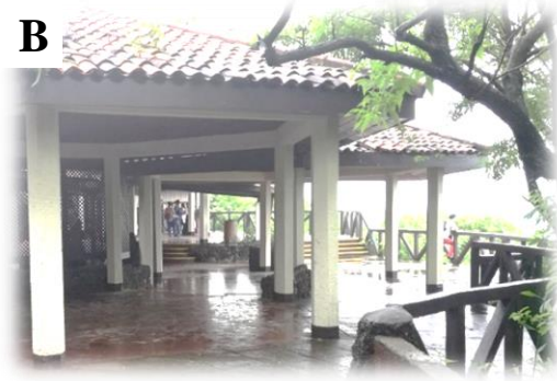
Imagen 50. Vista suroeste. Área del mirador a cielo abierto para personas capacidad diferentes. Al fondo escaleras sin pasamanos.
