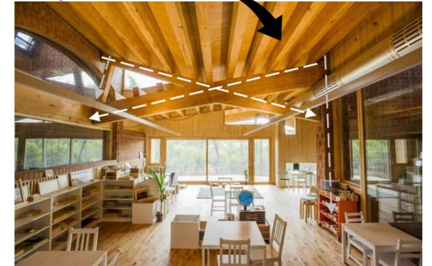
Figura 67: Análisis constructivo de estructura de techo. Fuente: arquitectura empresa
