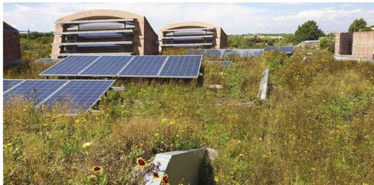
Figura 60: Cubierta verde, paneles solares, captadores y lamas de protección solar. Fuente: Zero Consulting
