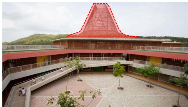
Figura 86: Sistema de muros estructurales, volúmenes de cubierta en estructura metálica triangulada. Fuente: CNI Ingenieros
