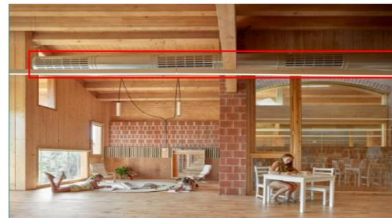
Figura 52: Sistema de climatización con tecnología VRV (Caudal refrigerante variable). Fuente: Imagine Montessori La Pinada
