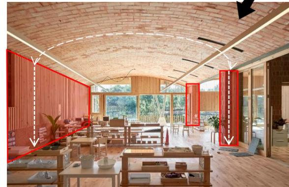
Figura 68: Análisis constructivo por arco de medio punto. Fuente: arquitectura empresa
