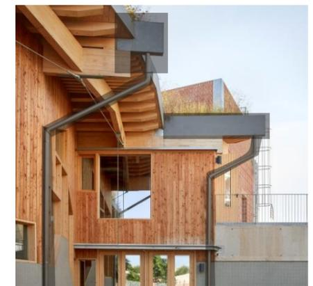
Figura 57: Conductores de captación de agua pluvial. Fuente: Imagine Montessori La Pinada
