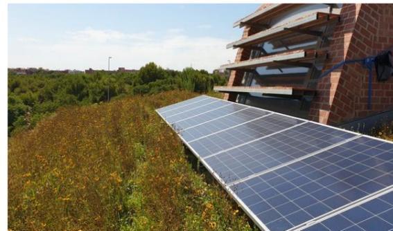
Figura 59: Cubierta verde, paneles solares, captadores y lamas de protección solar. Fuente: Zero Consulting
