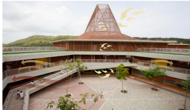
Figura 80: Circulación del viento dentro del edificio - Fuente: Autoras
