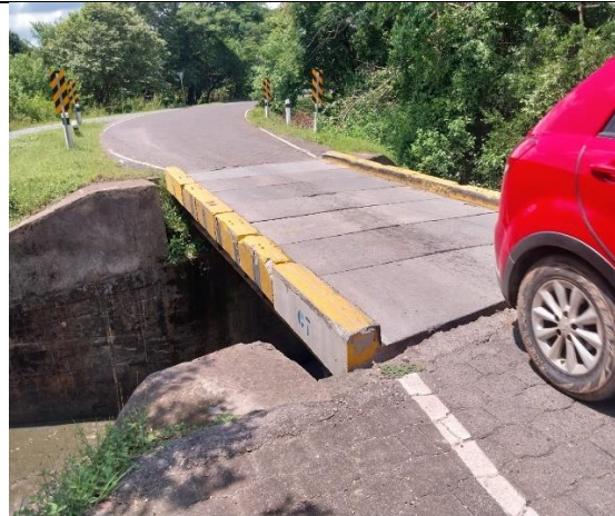
Ilustración 44. Puente Galilao con piso de losetas de concreto en estación 130+100
