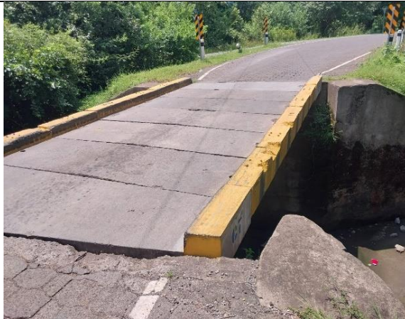
Ilustración 43. Puente Galilao con piso de losetas de concreto en estación 130+100
