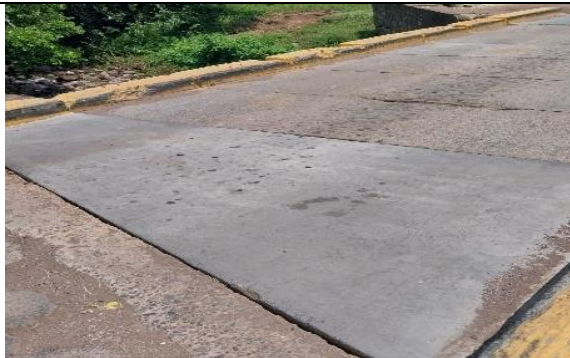
Ilustración 43. Puente Galilao con piso de losetas de concreto en estación 130+100
