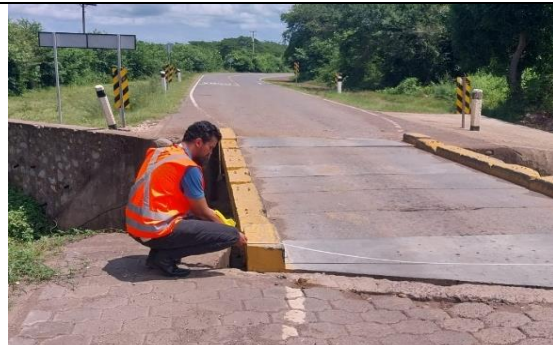
Ilustración 42. Puente de oro con piso de losetas de concreto en estación 126+790
