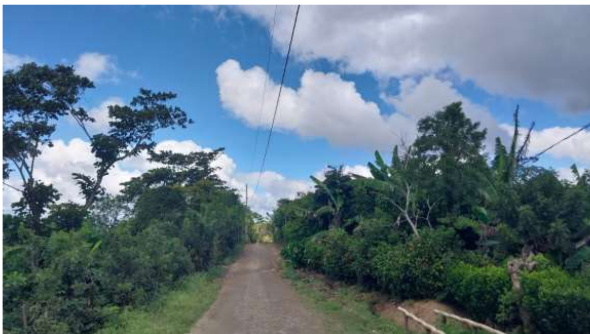
Anexo 6: Parte de donde pasa la línea de distribución
