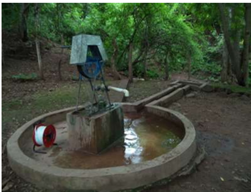
FIGURA 6. POZO PERFORADO EXISTENTE
