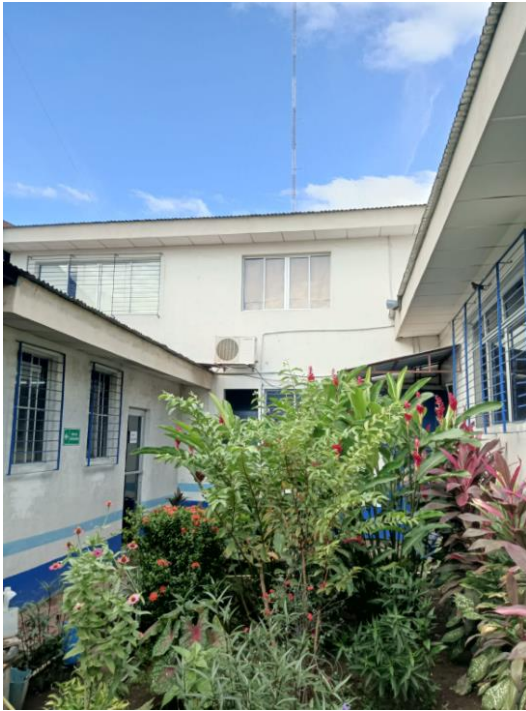
Ilustración 51 Vista al segundo piso.
