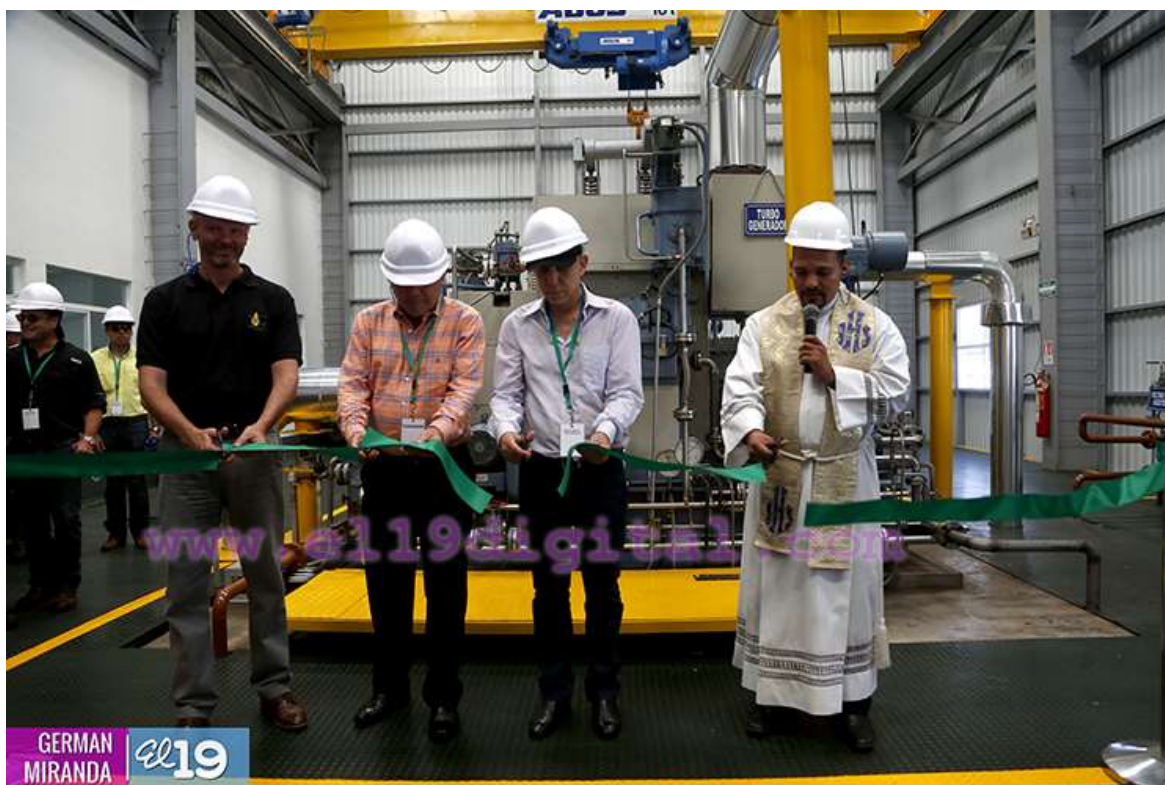
Ilustración 22 Planta eléctrica Aceitera el Real. Fuente: https://www.el19digital.com/articulos/ver/titulo:47116-inauguran-planta-de-generacion-electrica-y-planta-de-fraccionamiento-de-aceite-de-palma-en-chinandega .
