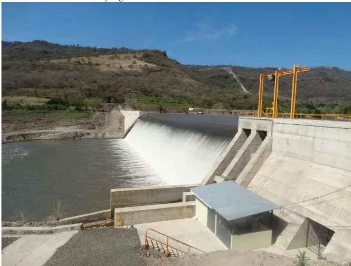
Ilustración 16 Planta Larreynaga. Fuente: https://www.cobraih.com/proyecto/central-hidroelectrica-de-larreynaga/ .
