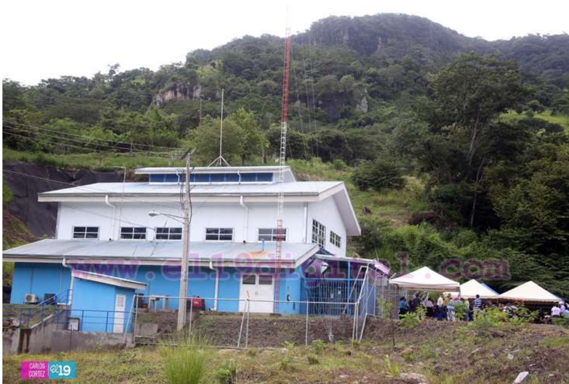
Ilustración 18. Planta Hidroeléctrica El Diamante inicia operaciones en San Ramón. Fuente: https://www.el19digital.com/articulos/ver/titulo:48038-planta-hidroelectrica-el-diamante-inicia-operaciones-en-san-ramon
