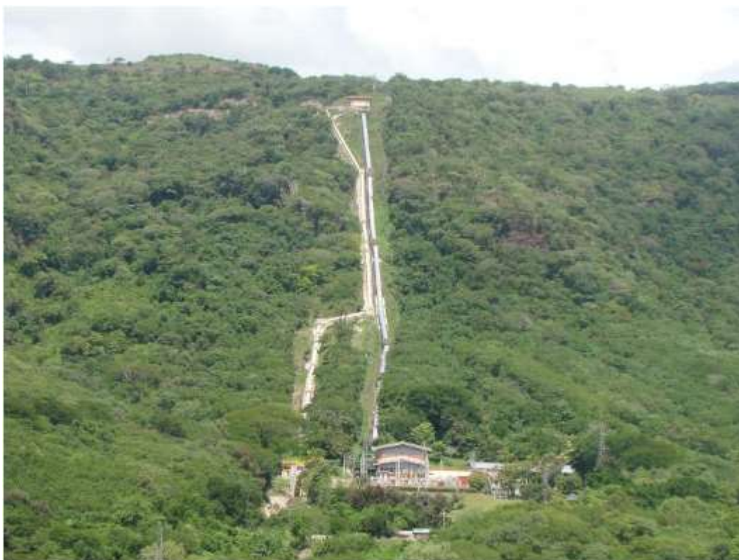
Ilustración 17. Vista panorámica de PCS y Tuberías de presión. Fuente: https://enel.gob.ni/hidrogeneradora-sa-hidrogesa/ .
