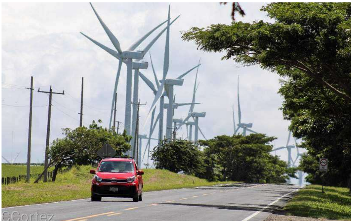
Ilustración 7 Consorcio eólico AMAYO S.A. Fuente: https://www.el19digital.com/articulos/ver/titulo:133733-amayo-transformando-la-fuerza-del-viento-en-energia-limpia-en-nicaragua .
