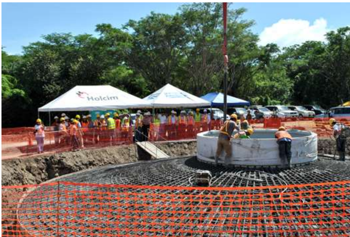
Ilustración 8 La fe San Martin-Holcim. Fuente: https://www.holcim.com.ni/quienes-somos/ultima-edicion/latest-release/article/concluye-con-exito-primera-fase-de-parque-eolico-la-fe-san-martin .
