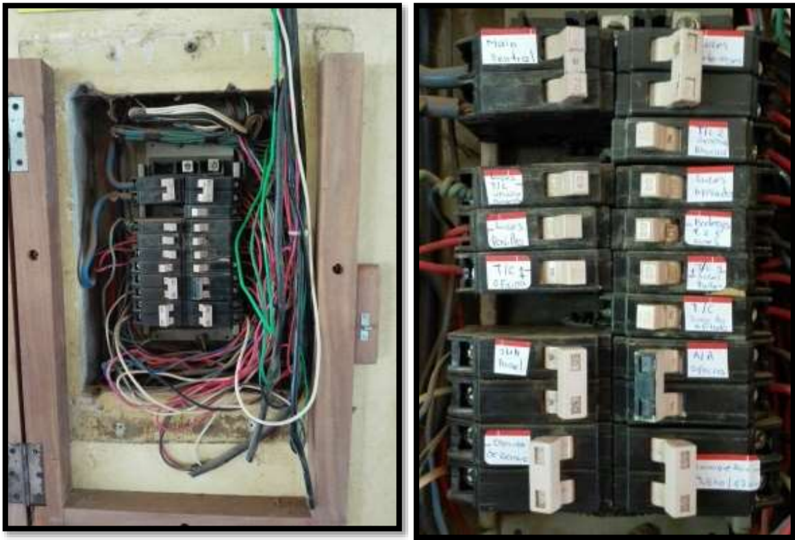
Ilustración.10. Antes y después de la rotulación de paneles
