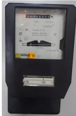
Fig. 5: Contador De Energía Trifásico - Marca Schlumberger (todocoleccion, s.f.)
