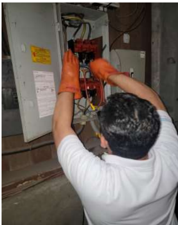
Figura No.35, Instalación de Analizador de Red en Almacén - APC
