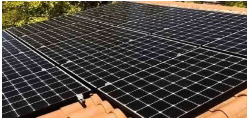
Figura No.10 , Panel Solar Monocristalino. (Hilcu, M. 2023).
