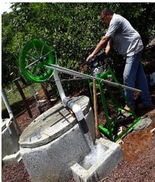
Anexo 19: Bomba de mecate instalada
