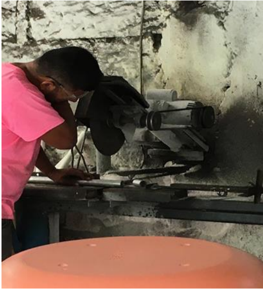
Anexo 9: Operario cortando tubos PVC
