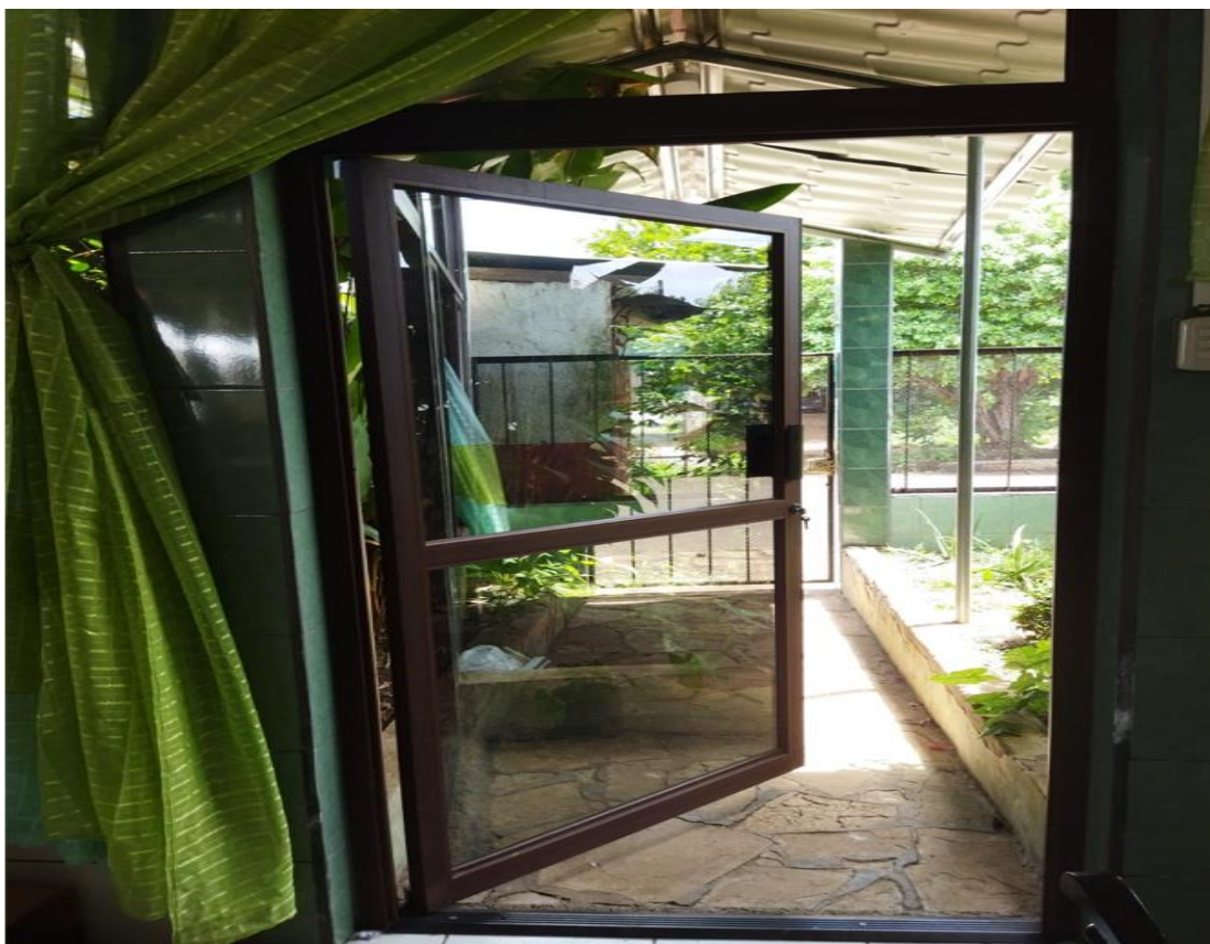
Figura N° 6. Puerta de pasadizo
