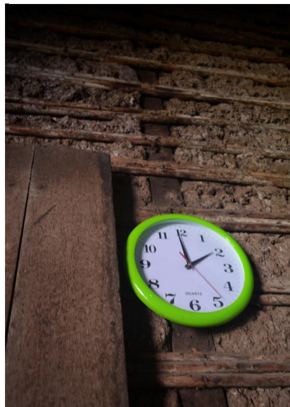
Figura 117. Sistema constructivo de taquezal de la vivienda de la Sra. Amparo Madrigal
