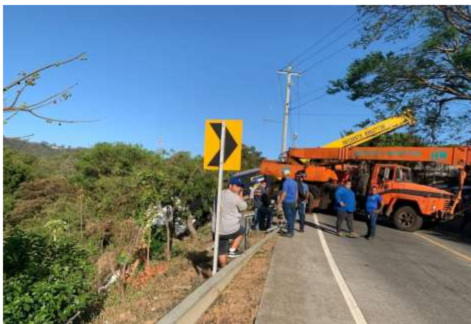
Figura 11 Vista del sector crítico en el km 15, donde la rastra impactó la barrera metálica de seguridad
