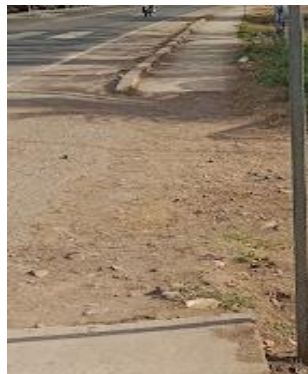
Figura 92. CUNETA LATERAL - ESTACION 185+700
