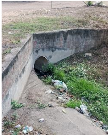
Figura 81. ALCANTARILLA TUBULAR – ESTACION 185+400
