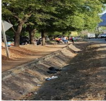
Figura 84. CUNETA LATERAL – ESTACION 184+600
