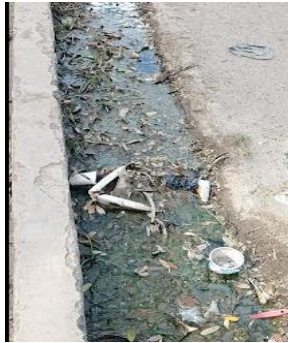
Figura 87. CUNETA LATERAL TIPO GUIA – ESTACION 185+200
