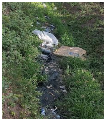
Figura 89. CUNETA LATERAL TIPO GUIA – ESTACION 185+400
