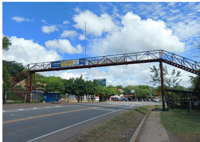
Figura 95. PUENTE INSTITUTO MARISTA – ESTACION 184+770
