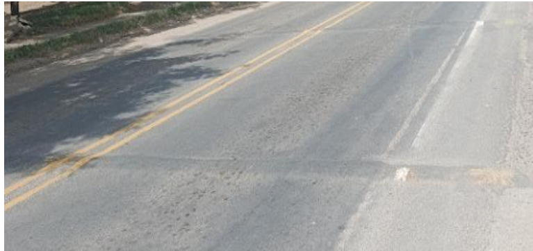
Figura 42. SEÑAL HORIZONTAL ESTACION 185+910
