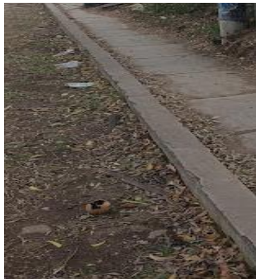
Figura 88. CUNETA LATERAL TIPO GUIA – ESTACION 185+300
