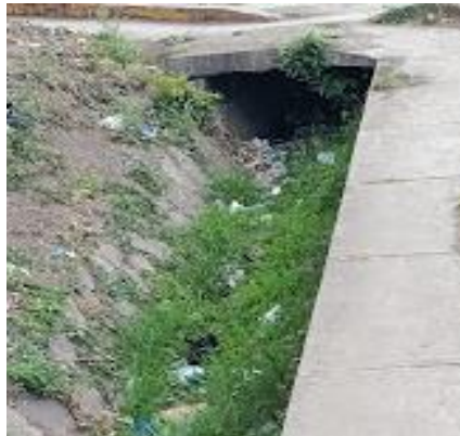
Figura 79. ALCANTARILLA TIPO CAJON – 185+000
