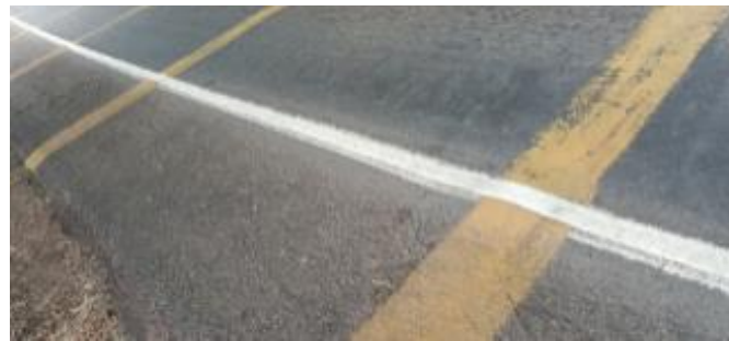
Figura 49. PELADURA – ESTACIÓN 184+300
