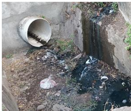
Figura 80. ALCANTARILLA TUBULAR – ESTACION 185+100
