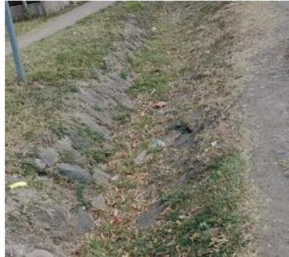
Figura 85. CUNETA LATERAL – ESTACION 184+700
