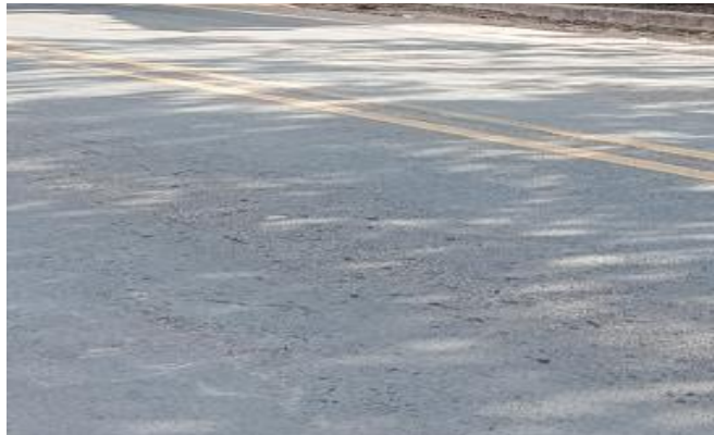
Figura 58. PELADURA – ESTACIÓN 185+200
