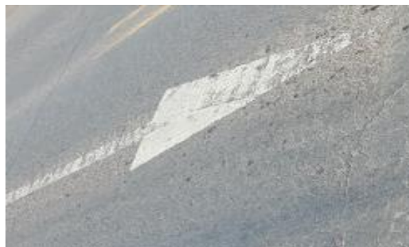
Figura 32. SEÑAL HORIZONTAL ESTACION 184+840
