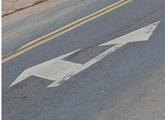
Figura 45. SEÑAL HORIZONTAL ESTACION 186+140
