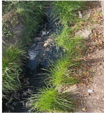
Figura 90. CUNETA LATERAL TIPO GUIA – ESTACION 185+500
