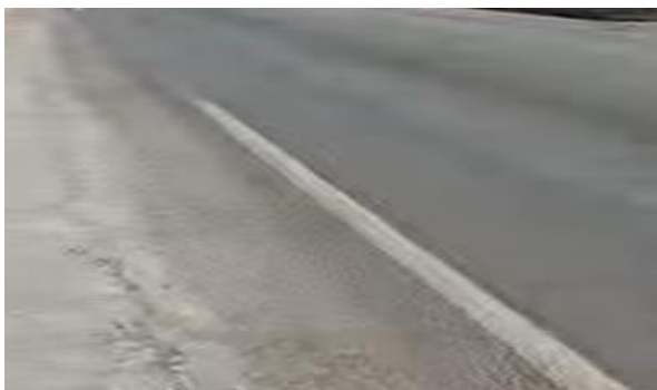
Figura 71. PELADURA – ESTACION 186+500
