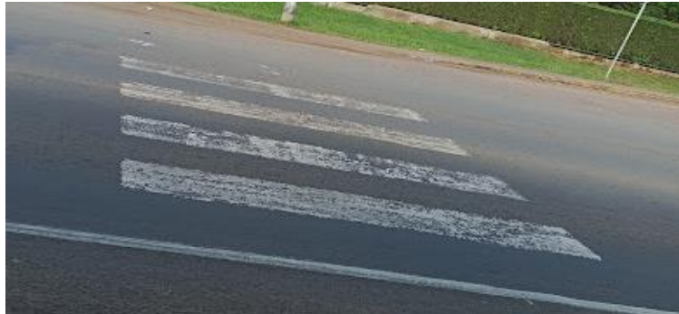
Figura 51. PELADURA – ESTACION 184+500
