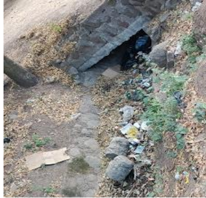
Figura 78. ALCANTARILLA TIPO CAJON – ESTACION 184+800
