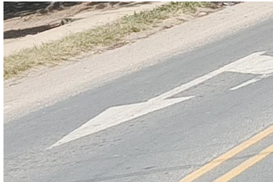
Figura 41. SEÑAL HORIZONTAL ESTACION 185+530
