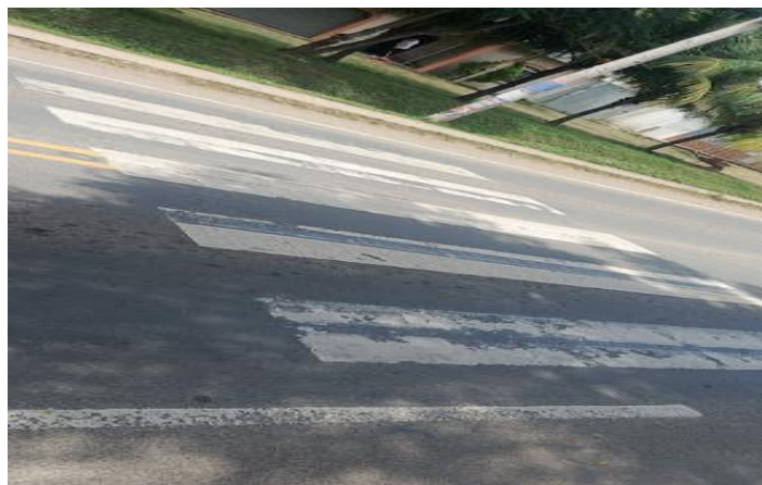
Figura 35. SEÑAL HORIZONTAL ESTACION 185+140
