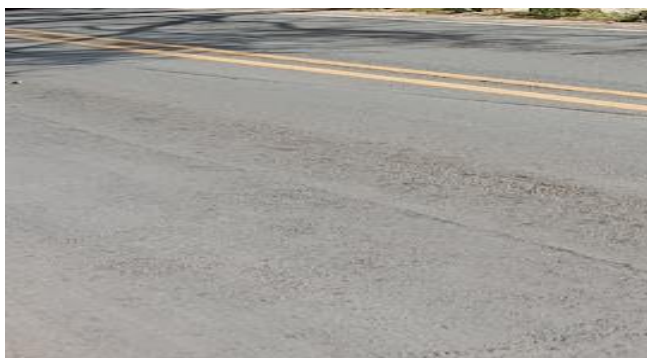
Figura 67. PELADURA - ESTACION 186+100
