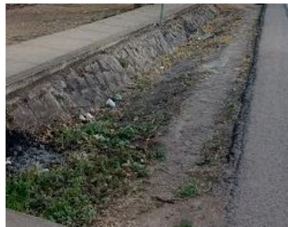
Figura 83. CUNETA LATERAL – ESTACION 184+500
