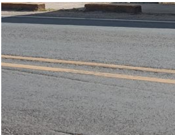
Figura 68. PELADURA - ESTACION 186+200
