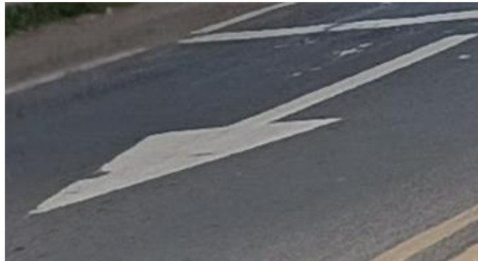
Figura 43. SEÑAL HORIZONTAL ESTACION 185+990
