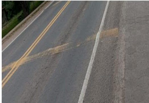
Figura 64. PELADURA - ESTACION 185+800
