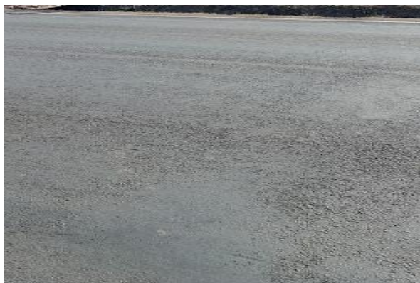
Figura 70. SEÑAL HORIZONTAL ESTACION 186+400
