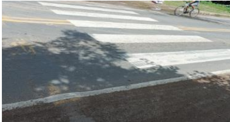
Figura 57. PELADURA – ESTACIÓN 185+100
