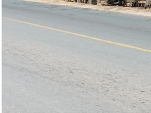
Figura 75. PELADURA – ESTACION 186+900
