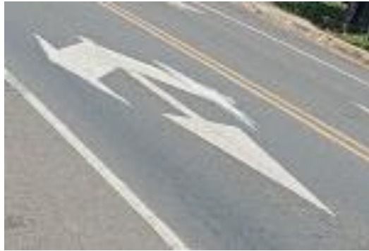
Figura 30. SEÑAL HORIZONTAL ESTACION 184+790
