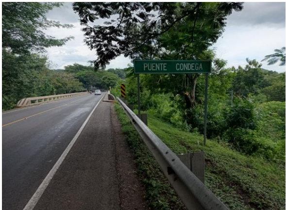
Figura 2. Entrada a Condega – Estación 184+000
