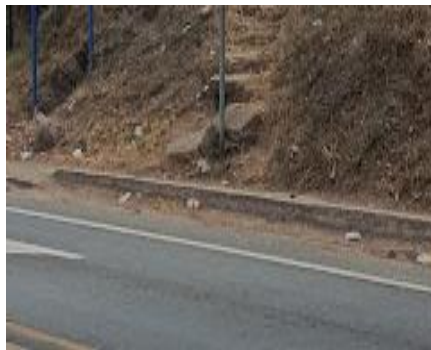
Figura 94. CUNETA LATERAL TIPO GUIA – ESTACION 186+000
