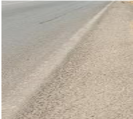
Figura 72. PELADURA – 186+600
