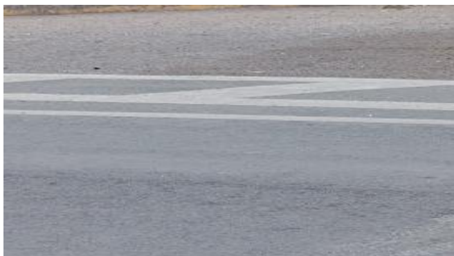
Figura 59. PELADURA – ESTACIÓN 185+300
