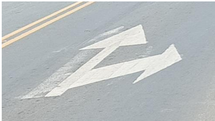
Figura 44. SEÑAL HORIZONTAL ESTACION 185+990
