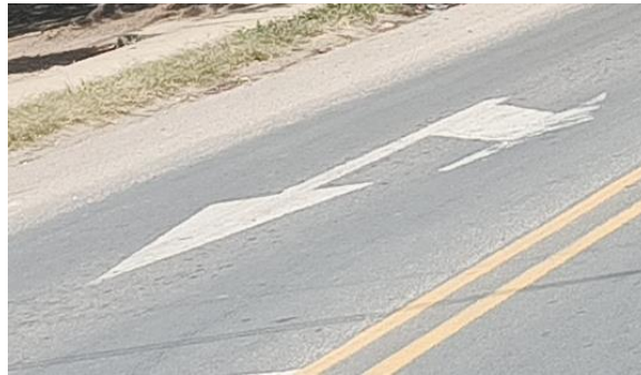
Figura 40. SEÑAL HORIZONTAL ESTACION 185+350
