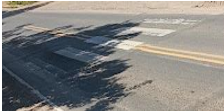
Figura 34. SEÑAL HORIZONTAL ESTACION 185+010
