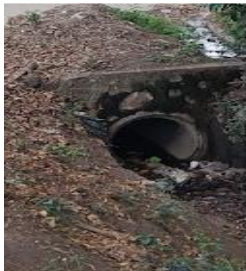
Figura 77. ALCANTARILLA TUBULAR – ESTACION 184+700
