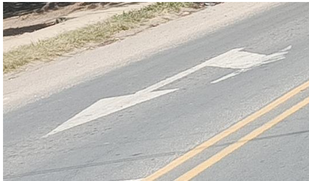
Figura 37. SEÑAL HORIZONTAL ESTACION 185+280
