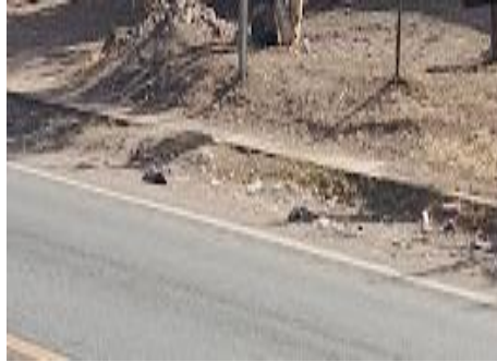
Figura 93. CUNETA LATERAL TIPO GUIA – ESTACION 185+900
