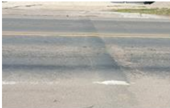
Figura 29. SEÑAL HORIZONTAL ESTACION 184+730
