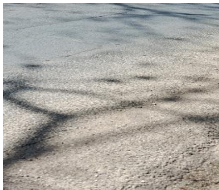
Figura 74. PELADURA – ESTACION 186+800
