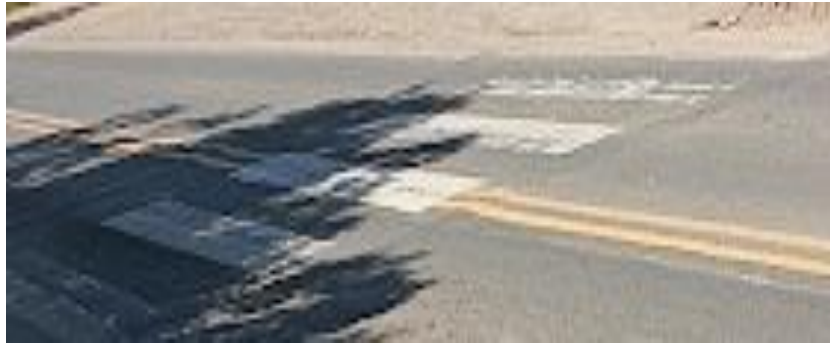
Figura 27. SEÑAL HORIZONTAL ESTACION 184+490
