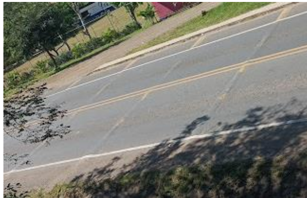
Figura 28. SEÑAL HORIZONTAL ESTACION 184+640
