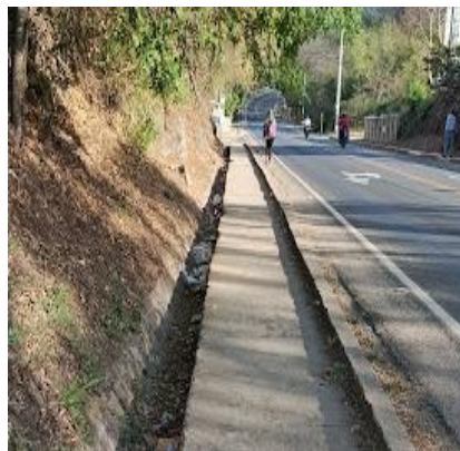
Figura 82. CUNETA LATERAL – ESTACION 184+400
