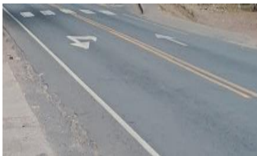
Figura 66. PELADURA - ESTACION 186+000
