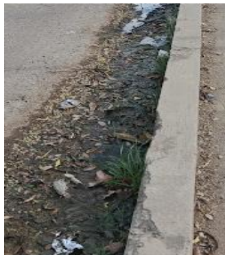
Figura 86. CUNETA LATERAL TIPO GUIA – ESTACION 185+100
