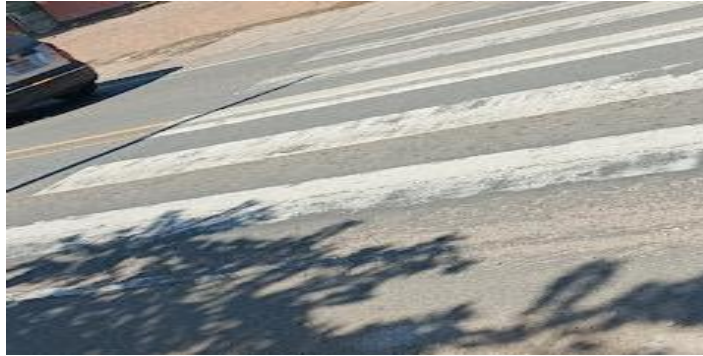
Figura 33. SEÑAL HORIZONTAL ESTACION 184+890
