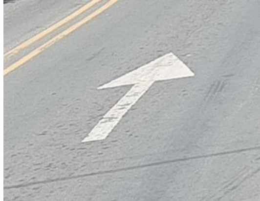
Figura 39. SEÑAL HORIZONTAL ESTACION 185+350
