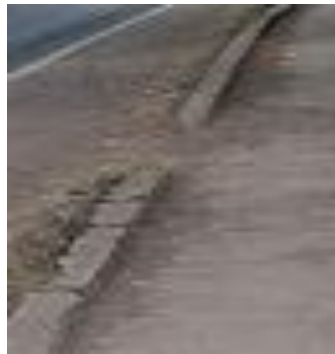
Figura 91. CUNETA LATERAL – ESTACION 185+600
