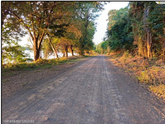
Ancho de rodamiento reducido Estación: 10+020
