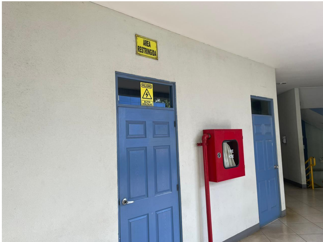
Figura No. 19 Cuarto de energía del ala A
