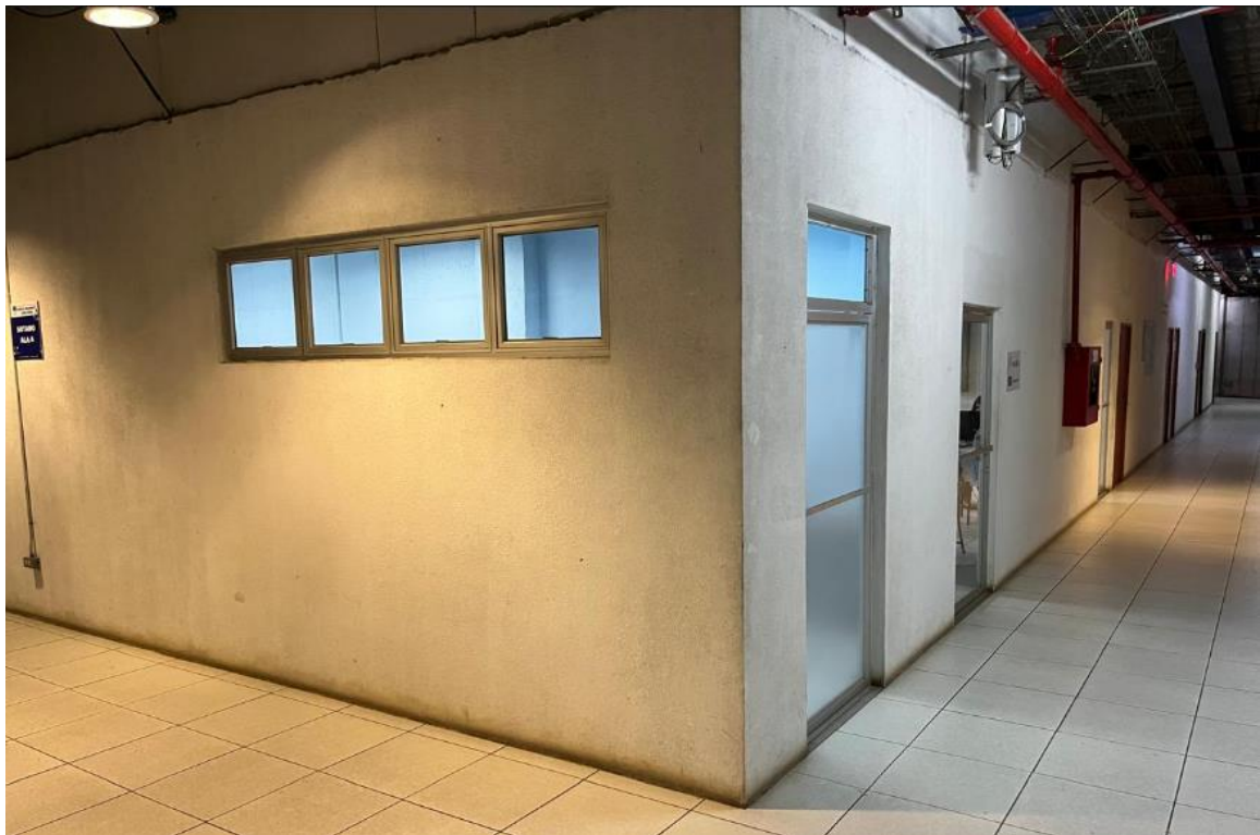
Figura No. 24 Oficina de dirección académica en el sótano del edificio Rigoberto Lopez Pérez
