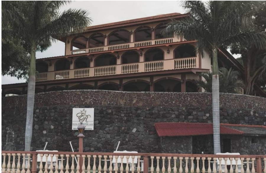
Figura No 18. (Imagen propia). Vista desde el primer nivel del hotel Reith Lake jardín y puerto
