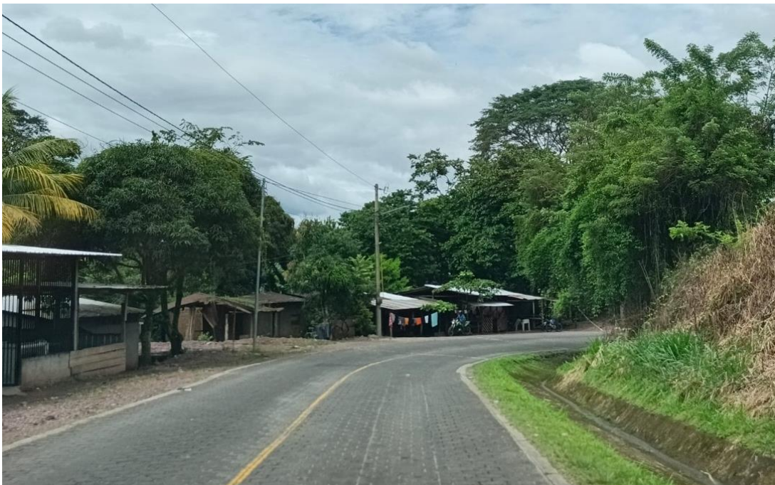
Ilustración 21. Puntos críticos sin señalización vial.
