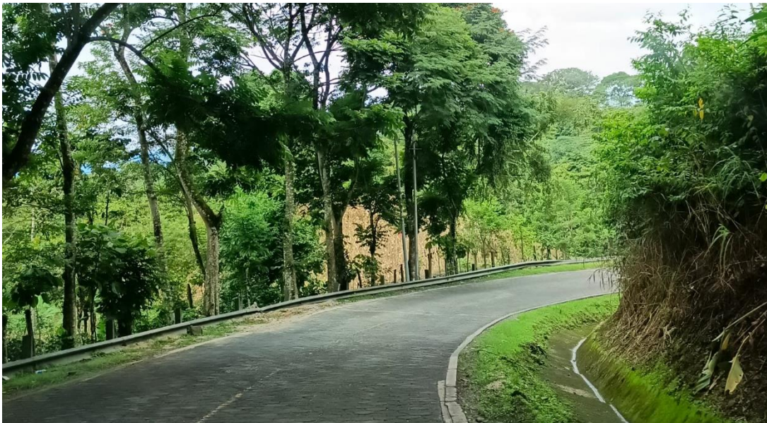
Ilustración 23. Puntos críticos sin señalización vial.
