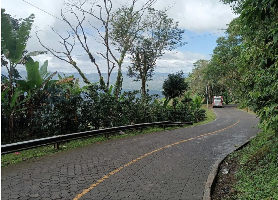
Ilustración 30. Puntos críticos sin señalización vial.
