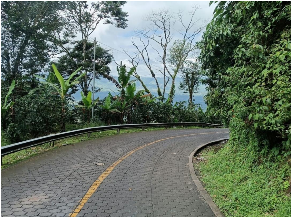
Ilustración 29. Puntos críticos sin señalización vial.
