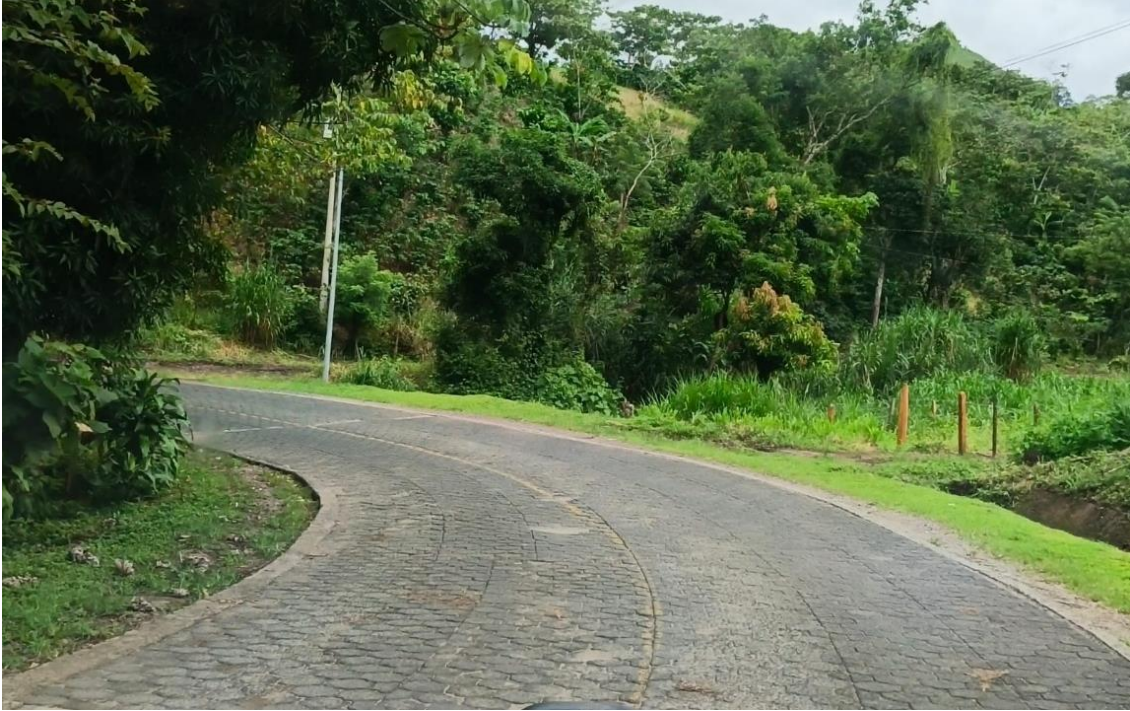
Ilustración 22. Puntos críticos sin señalización vial.
