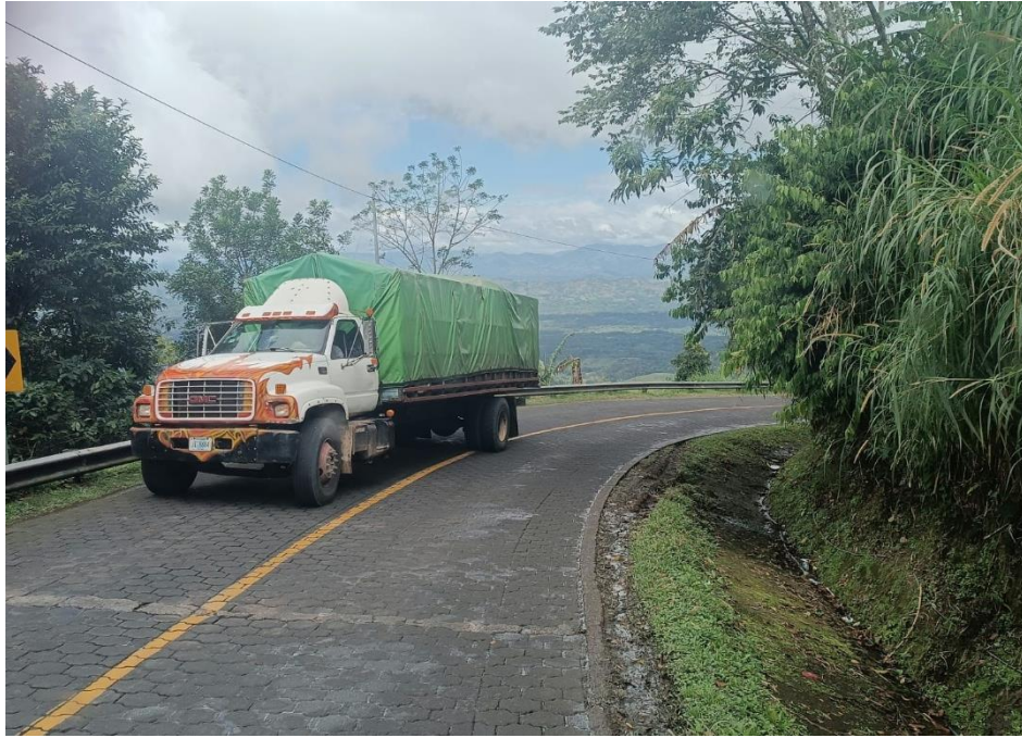
Ilustración 34. Puntos críticos sin señalización vial.
