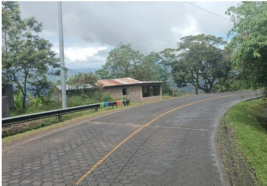
Ilustración 33. Puntos críticos sin señalización vial.
