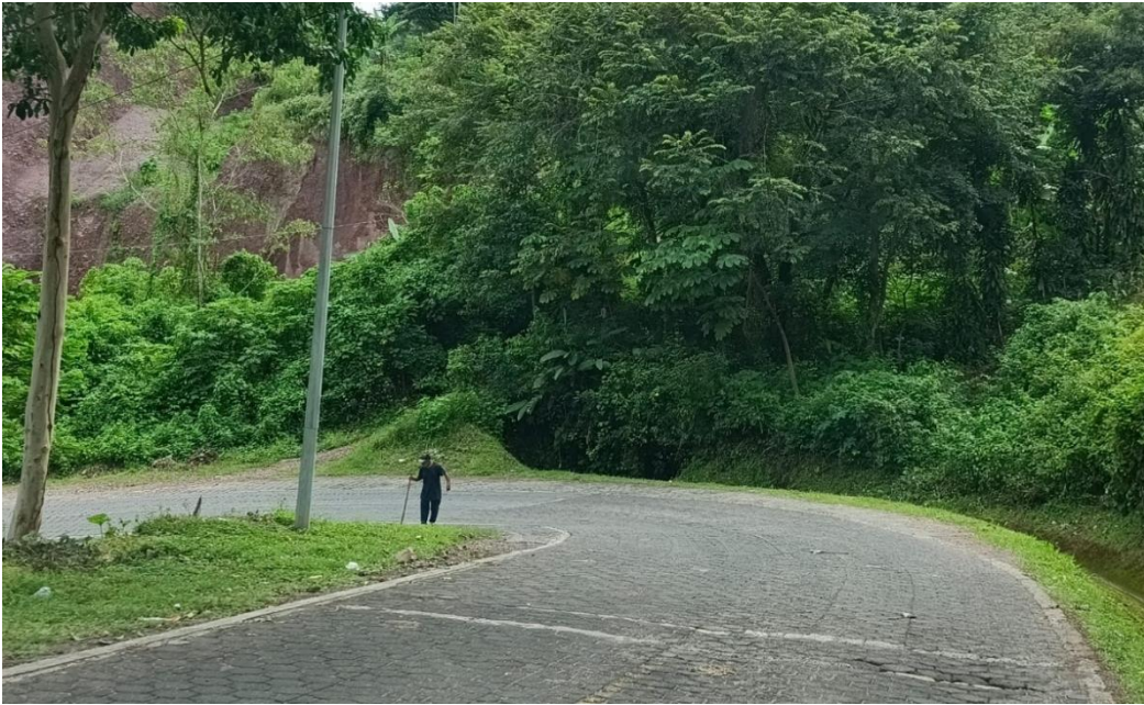
Ilustración 24. Puntos críticos sin señalización vial.
