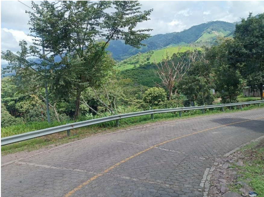
Ilustración 26. Puntos críticos sin señalización vial.
