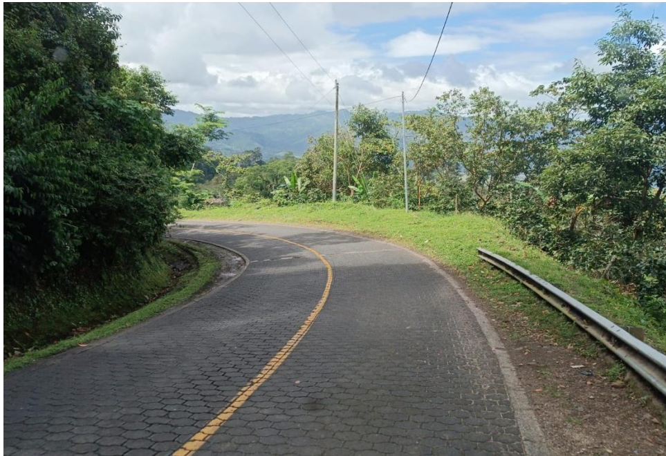
Ilustración 27. Puntos críticos sin señalización vial.
