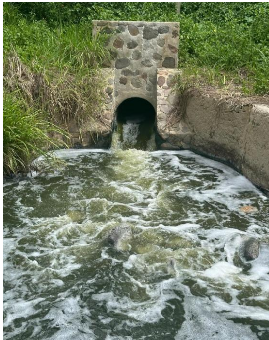
Figura 38. Descarga del efluente de la STAR de Estelí
