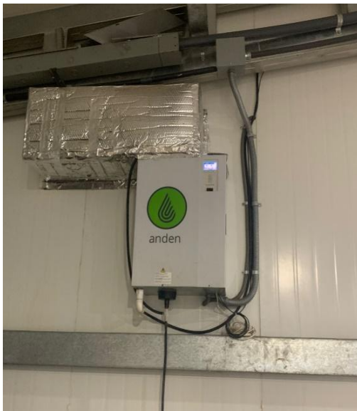
Figura 51. Contactos eléctricos Directos/Indirectos
