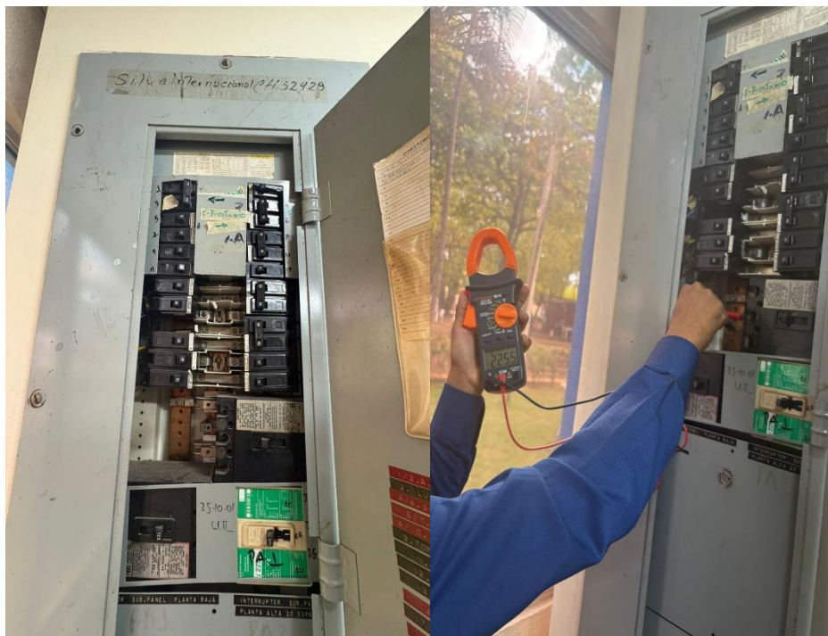
Figura A.3: Centro de carga principal correspondiente a la planta baja de la biblioteca.
