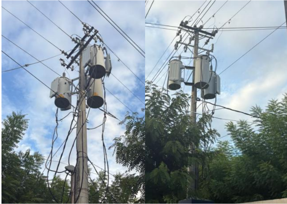
Figura A.8: Banco de transformadores de 3 x 75 kVA
