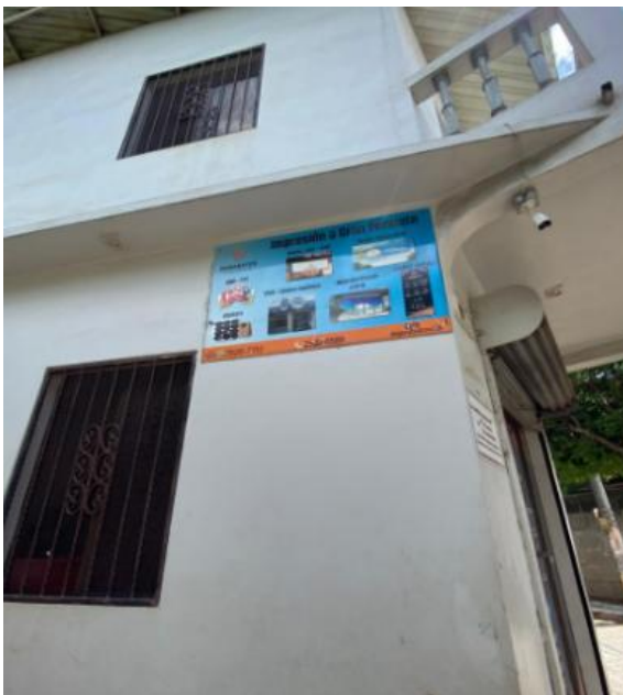
Anexo 82. Parte lateral del área de confección planta alta
