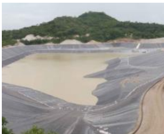
Figura.3 Vista general de la presa de relaves.
