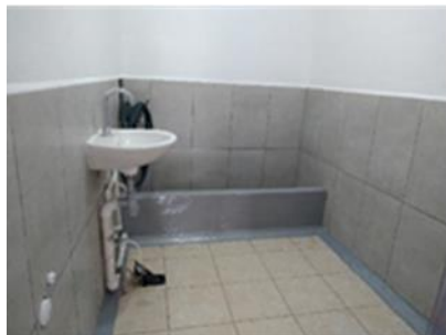
Figura 25: Cambios físicos del área del lavado de mano y botas. Muestra del desagüe antes existente.
