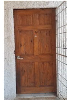
Figura 7 Puerta de ingreso del personal en la zona frontal
