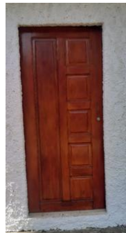
Figura 6 Puerta de salida de productos terminados hacia el área de vehículos en el costado de la planta
