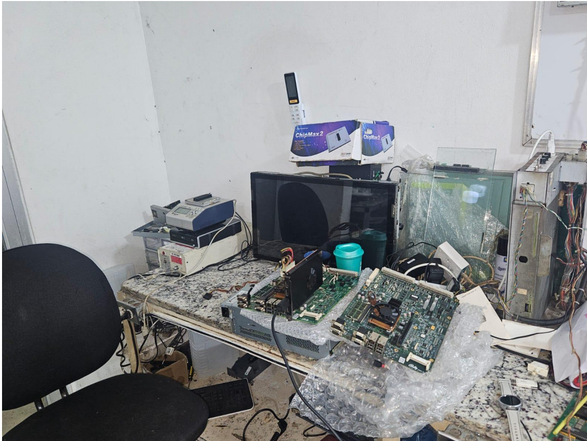
Fuente: PC 911- Imagen In situ, Managua Nicaragua (2026)
