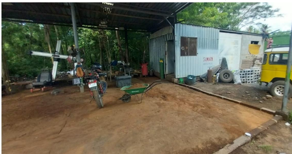
Ilustración 39. Embaldosado de estaciones de trabajo.
