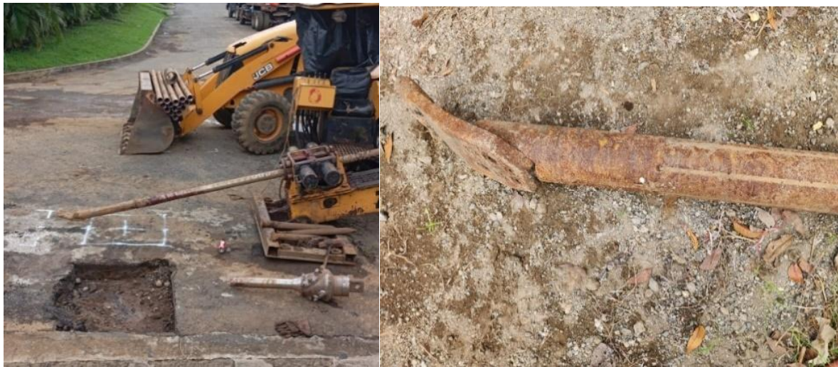
Figura No° 3 Perforación inicial o piloto
