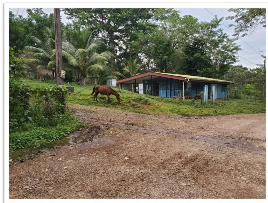
Figura 53 Condición actual del tramo
