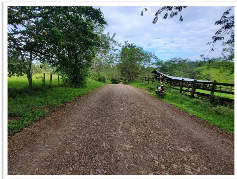
Figura 52 Condición actual del tramo
