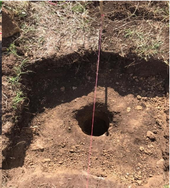
Ilustración 36 "Vista del agujero en el centro del área delimitada"
