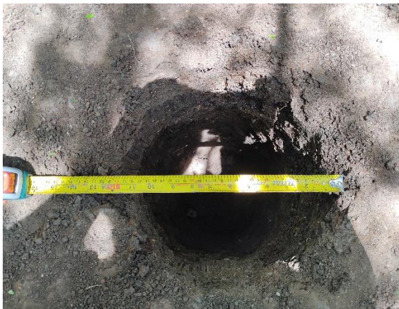
Ilustración 27 " Medición de diámetro del agujero"
