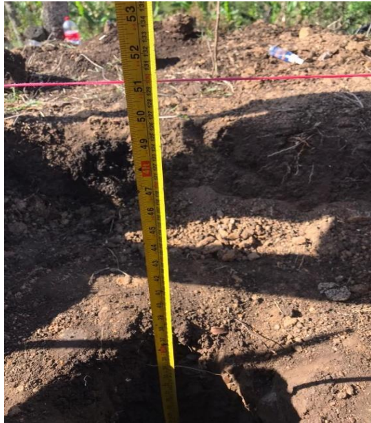
Ilustración 35 "Medición de altura del fondo del agujero a la niveleta"
