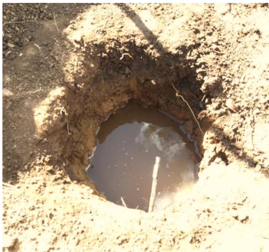
Ilustración 38 "Llenado de agua en la perforación para saturar el suelo"
