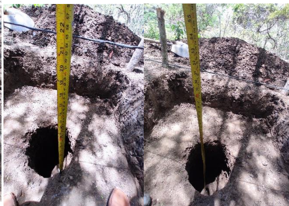
Ilustración 30 " Mediciones de la superficie a la niveleta y la altura del fondo del agujero a la niveleta"
