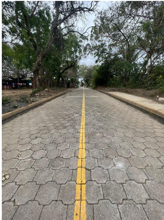
Ilustración 15 Obra de drenaje
