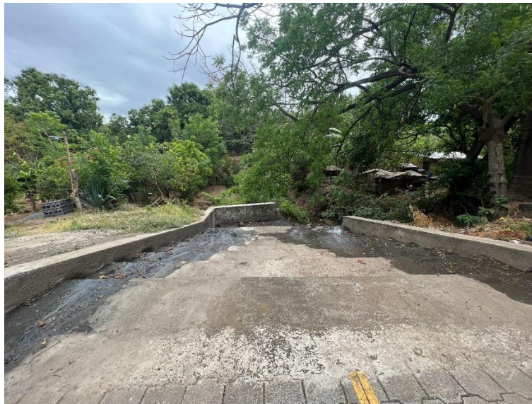
Ilustración 6 Obra de drenaje
