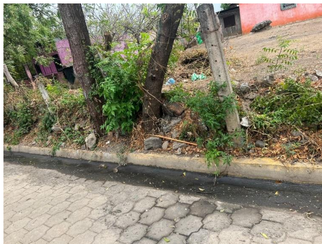
Ilustración 25 Obra de drenaje
