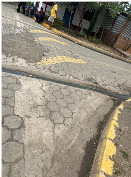
Ilustración 46 Obra de drenaje
