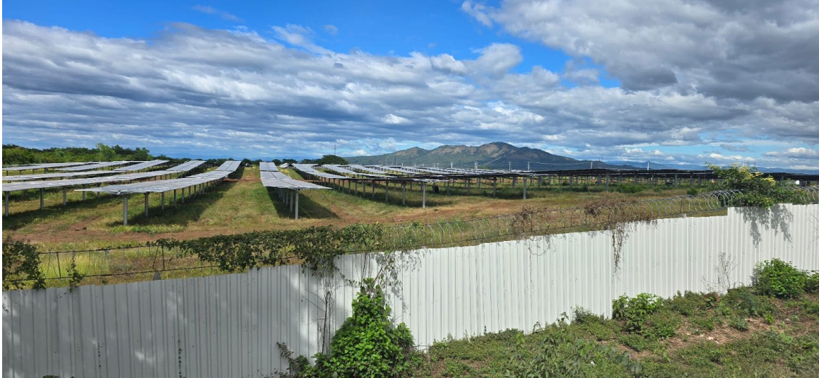
Figura 30. Planta de energía solar “El Jaguar”
