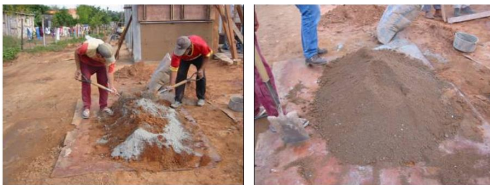
Figura 3 Preparación de mezcla de suelo y cemento
