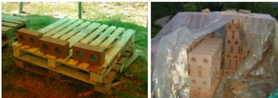
Figura 5 Curado y almacenamiento del BTC
