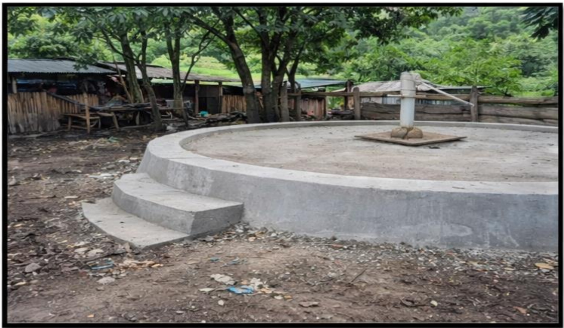
Figura 33. Bomba y pozo existente
