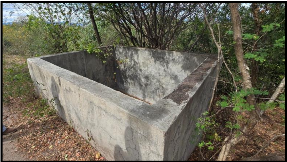
Figura 4: Pila existente a remover.
