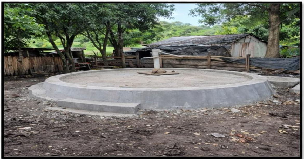
Figura 32. Bomba y pozo existente
