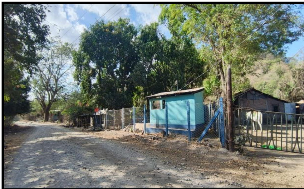
Figura 27. Caseta del pozo
