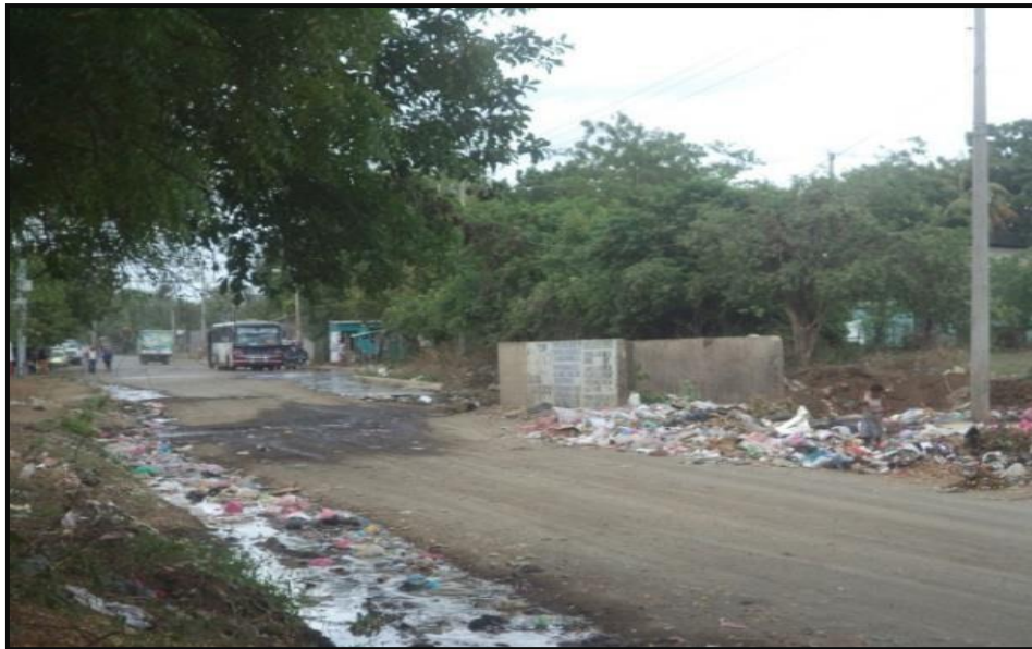
Figura 25. Situación Actual de Salida del Tramo Est 1+330
