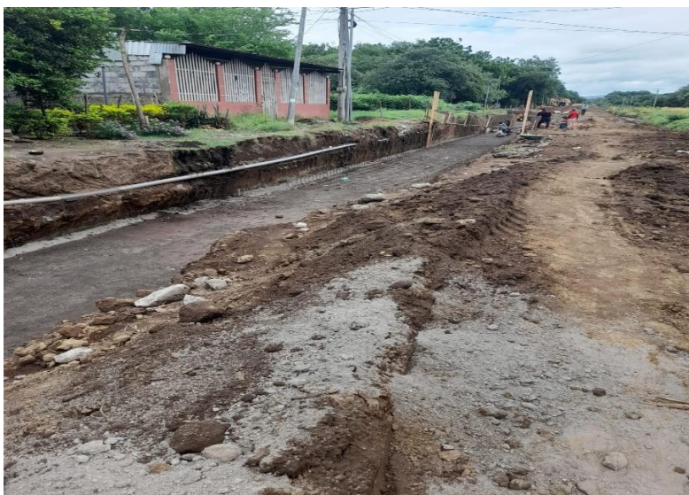
Figura 28. Estado actual del tramo de estudio
