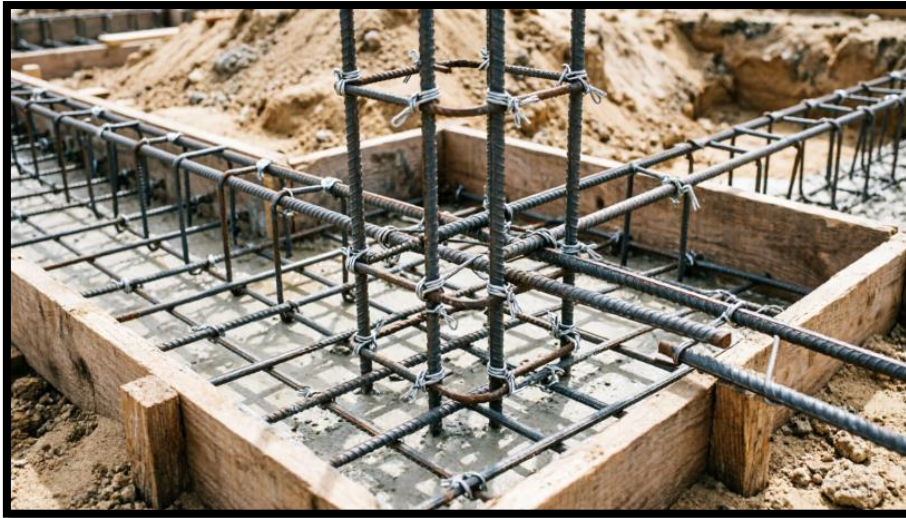
Figura 55. Relación entre malla de zapata y armado de viga en imagen de obra
