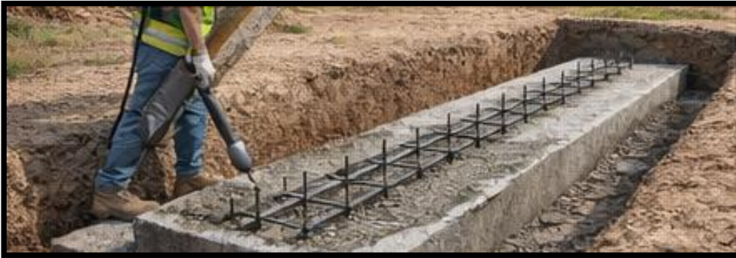
Figura 43. Colado y compactación del concreto en la zapata corrida.
