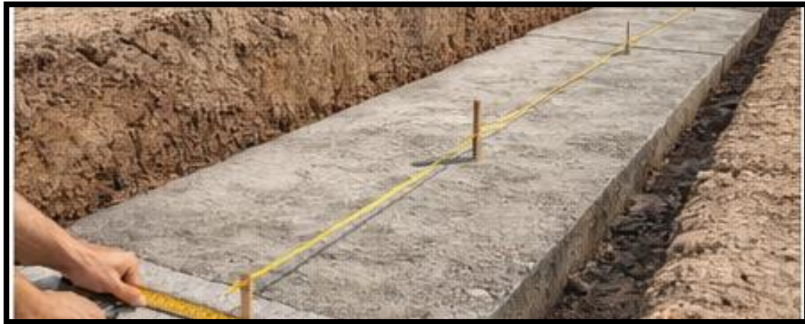
Figura 37. Replanteo del eje de la zapata sobre la plantilla.
