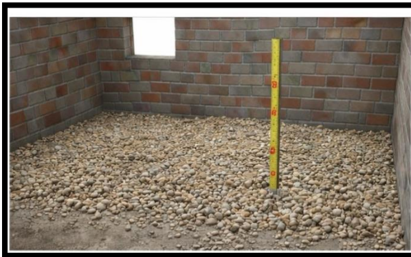
Figura 11. Colocación de relleno en capas de 5 cm.
