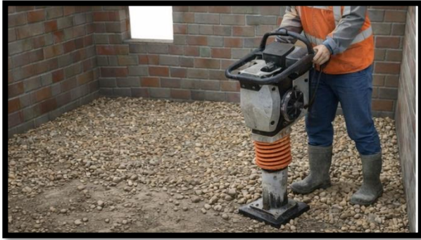
Figura 13. Compactación del relleno con bailarina
