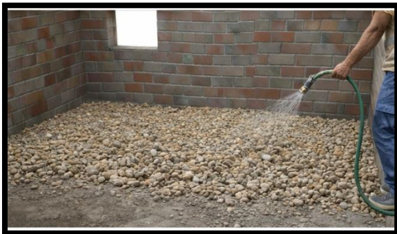
Figura 12. Evaluación de humedad y humedecimiento del relleno, si es necesario.
