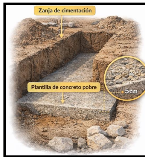
Figura 35. Ubicación de la plantilla de concreto pobre sobre el fondo de la zanja.
