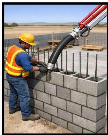
Figura 28. Relleno estructural de celdas
