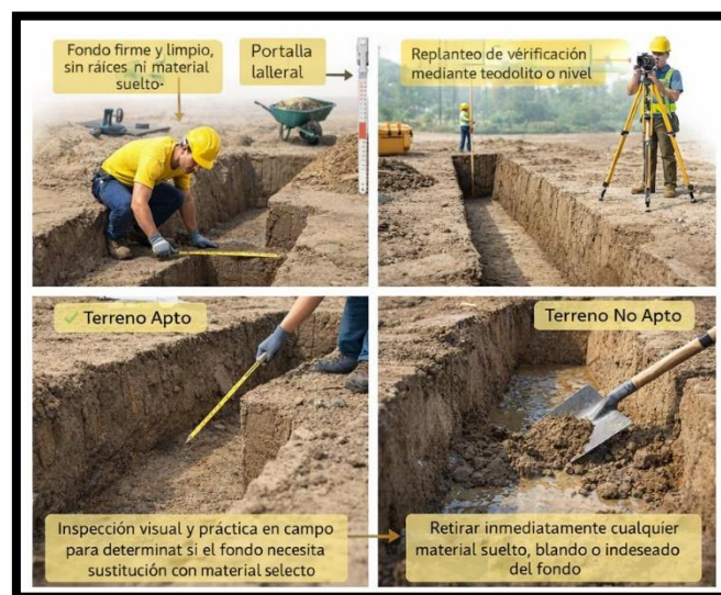
Figura 31. Inspección visual y práctica del fondo de zanja, verificación geométrica y determinación de aptitud del terreno.
