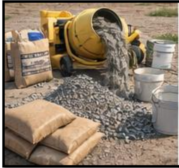
Figura 42. Preparación del concreto 3000 psi en trompo o mezcladora
