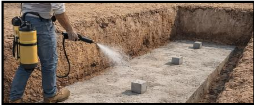
Figura 38. Tratamiento preventivo del fondo y laterales de excavación
